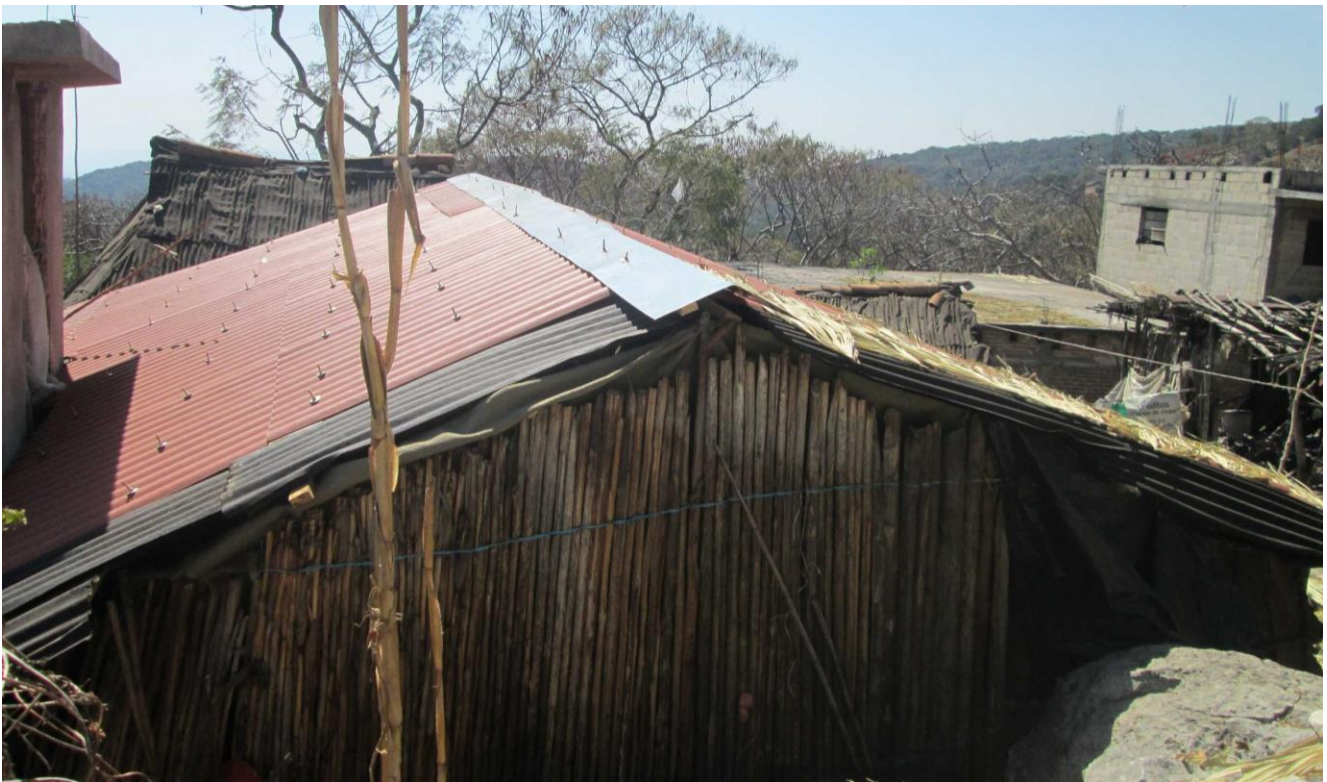
51 Foto de vivienda de ahuasol y acahual con lámina de ferrocemento.
