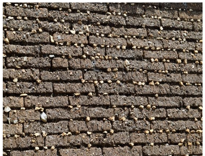
Foto 47 Viviendas de adobe, construidas por adoberos de Juliantla, propias 2017
