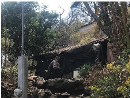
Vivienda de bajareque, cubierta con plástico, Barrio de Santiago
