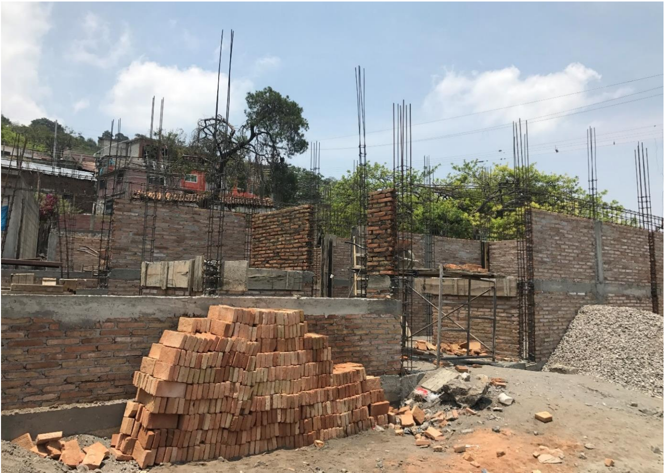
36, Construcción del nuevo Centro de Salud, Fuente, Propia, 2017
