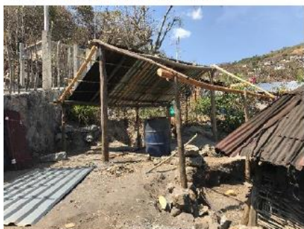
Construcción de vivienda, Barrio de San Juan
