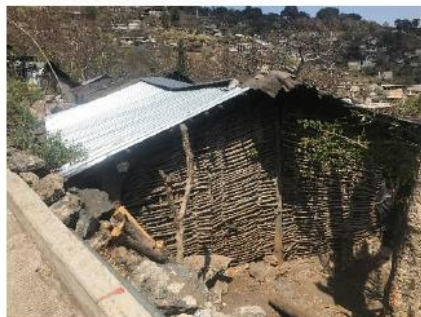
Vivienda de bajareque, Barrio de Santiago
