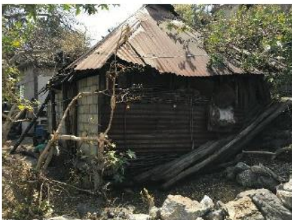
Vivienda de block, bajareque y lámina, Barrio de San Juan
