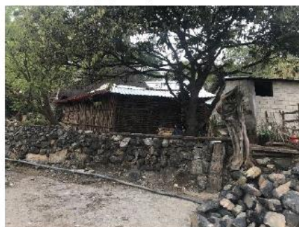
Vivienda de ahuasol y bajareque, Barrio de San Juan
