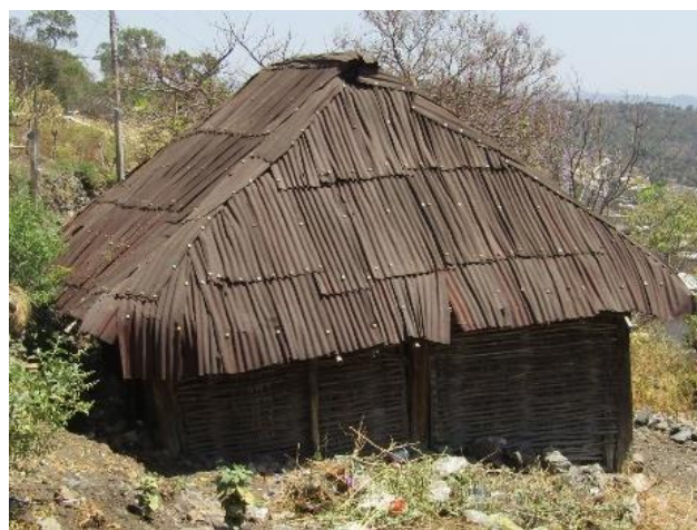
Foto 31 vivienda de techo de lámina y muros de bajareque, propia 2017
