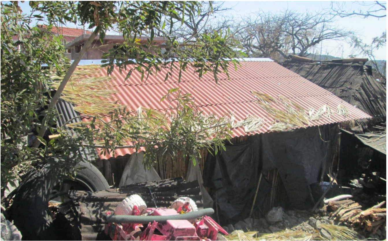
52 Foto de ahuasol y acahual con techo de lámina de ferrocemento.
