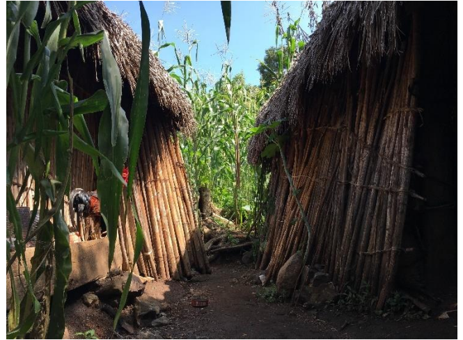
Foto 60 exterior de la vivienda de ahuasol
