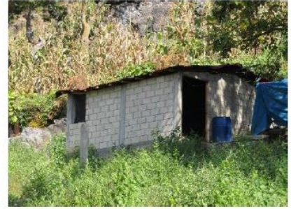
Vivienda de block, Barrio de San Juan
