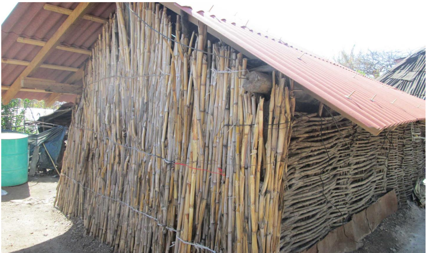
54 Foto, vivienda de ahuasol y bajareque con techo de lámina de ferrocemento
