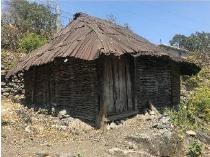
Vivienda de bajareque, Barrio de Santiago
