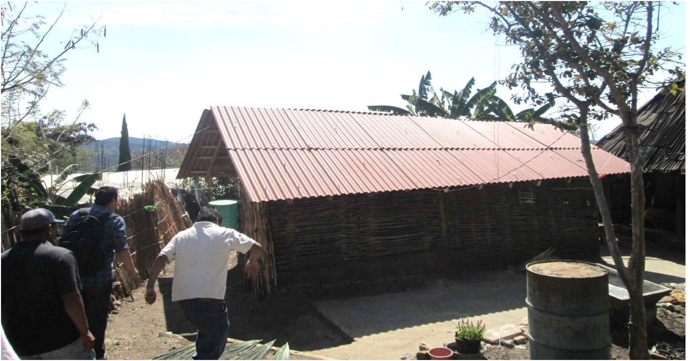
53 Foto, vivienda de ahuasol y bajareque con techo de lámina de ferrocemento.
