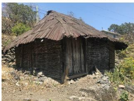
Vivienda de bajareque, Barrio de Santiago
