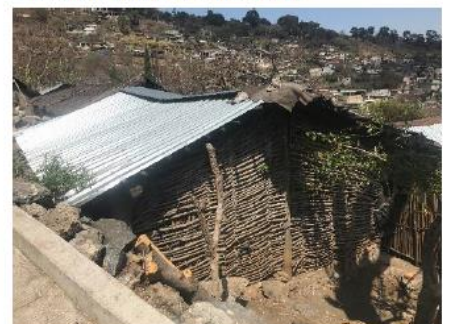
Vivienda de bajareque, Barrio de Santiago
