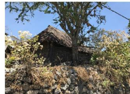
Vivienda de bajareque, Barrio de Santiago
