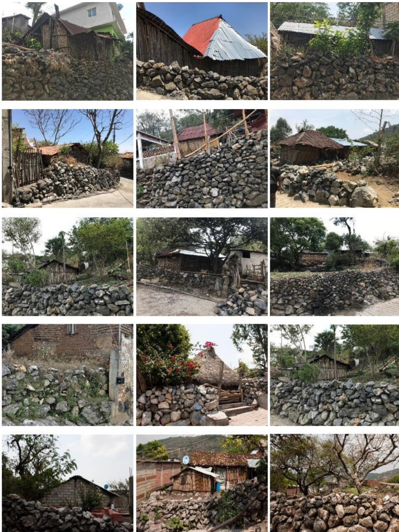
Foto 90 Los tecorrales son muros de piedra sin ningun aglutinante, los cuales se utilizan como muros divisorios entre los predios.
