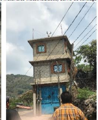
Vivienda de block, Barrio de San Juan
