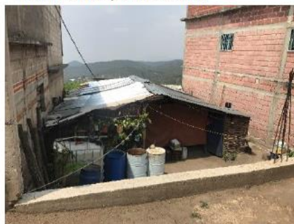
Vivienda de bajareque y lámina, Barrio de San Juan
