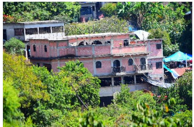
Foto 88 Transformación de vivienda, propia 2017
