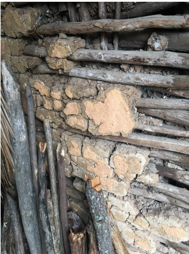
Foto 72 detalle constructivo, propia 2017
