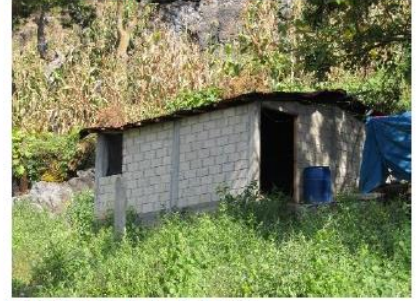
Vivienda de block, Barrio de San Juan
