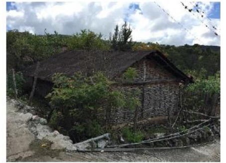
Vivienda de bajareque, Barrio de Santiago
