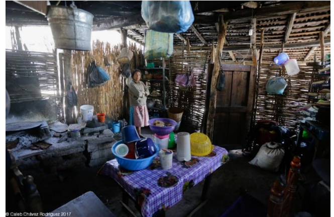
81 Interior de una cocina que originalmente fue de bajareque, se le ha dado mantenimiento con ahuasol y el techo de palma fue modificado por lámina.
