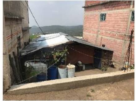
Vivienda de bajareque y lámina, Barrio de San Juan
