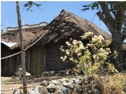
Vivienda de bajareque, Barrio de Santiago
