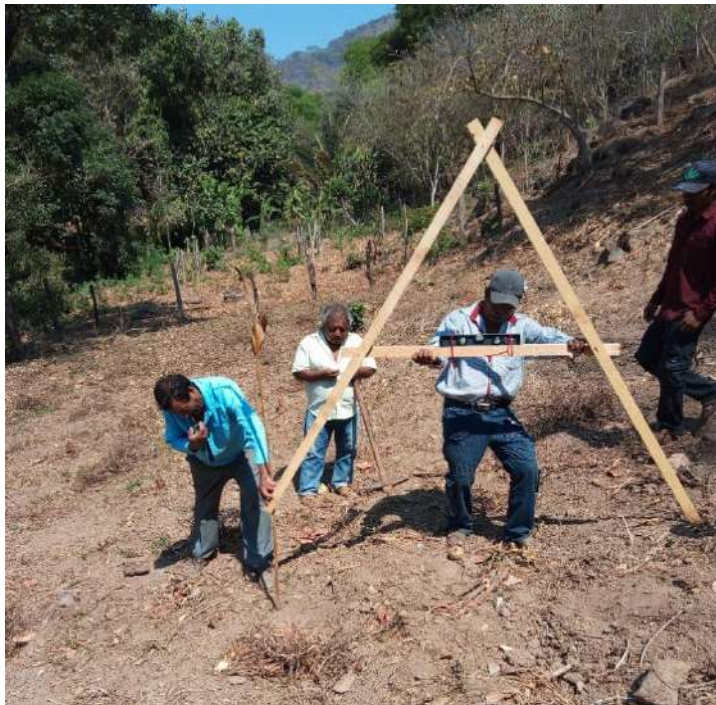
Figura 7. Marcación de la zanja a nivel
