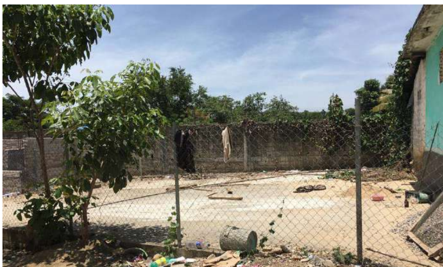
Figura 8. Deshidratador de piso firme y malla ciclónica. Fuente: Elaboración propia
