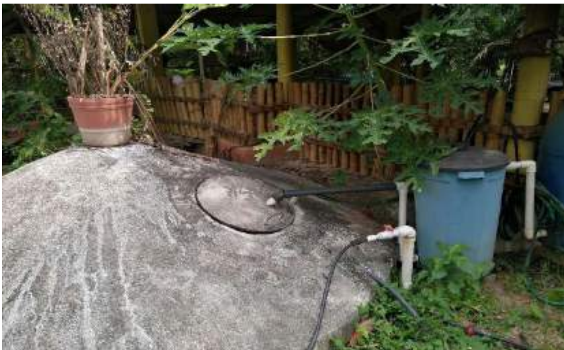
Ilustración 23 Cisterna de ferrocemento
