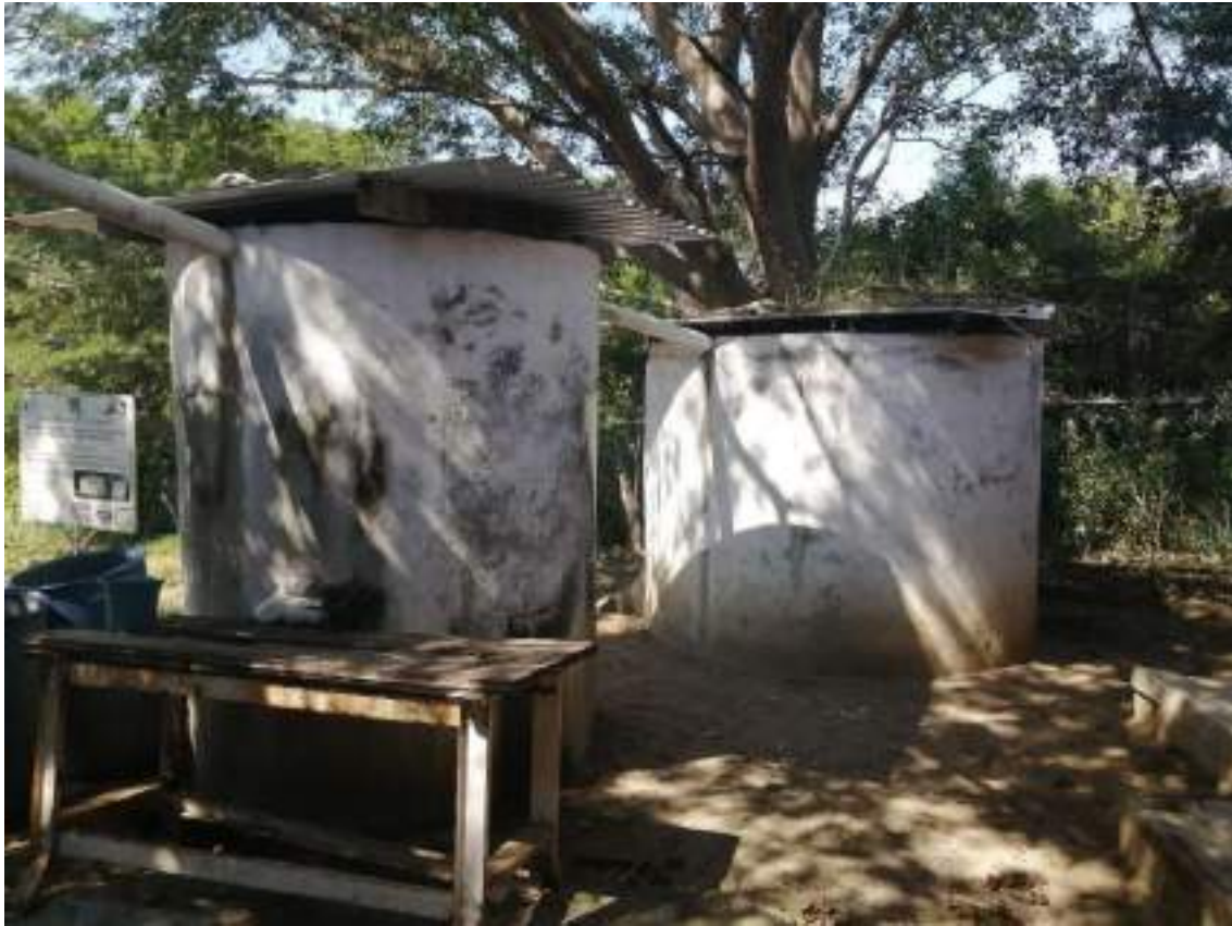
Ilustración 29 Almacenamiento del agua
