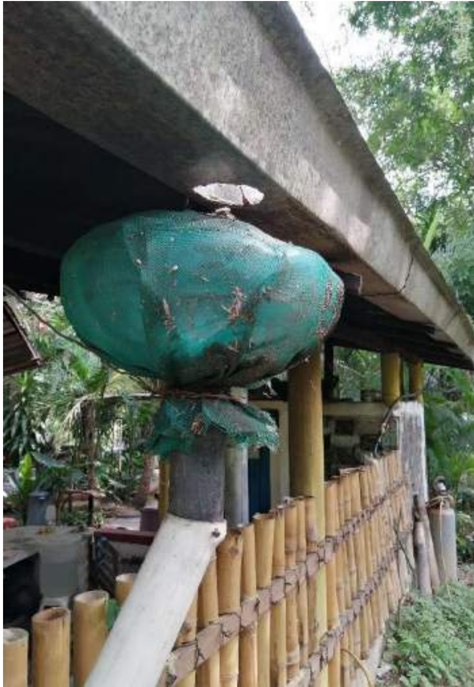
Ilustración 24 Embudo para filtración
