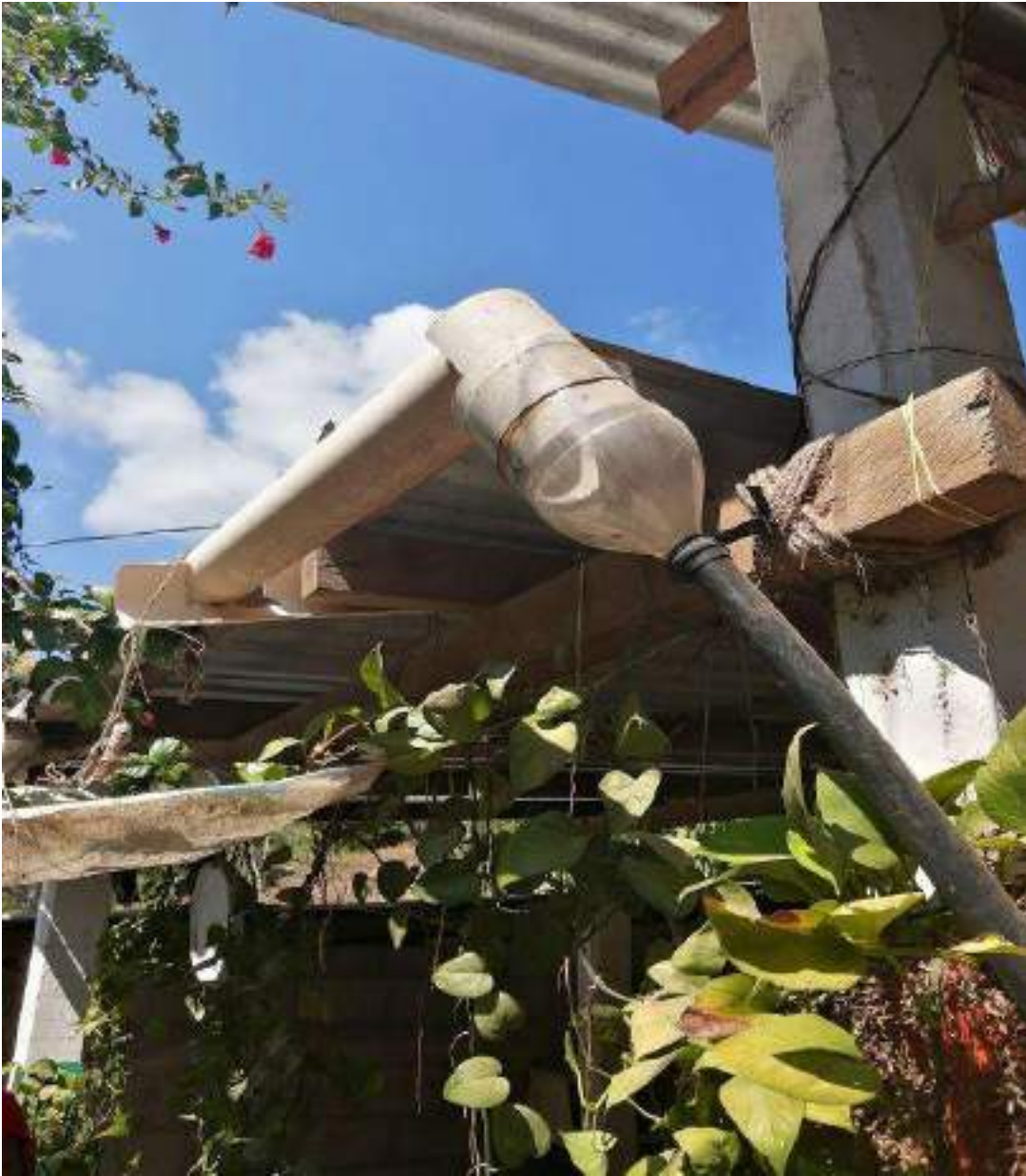
Ilustración 26 Canaletas de conducción
