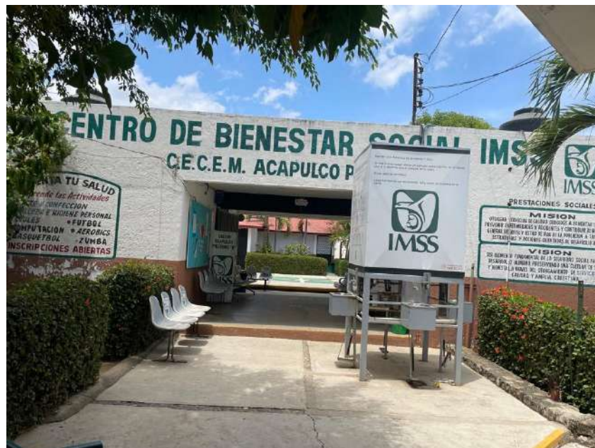
Ilustración 12 Instalaciones del CECEM
