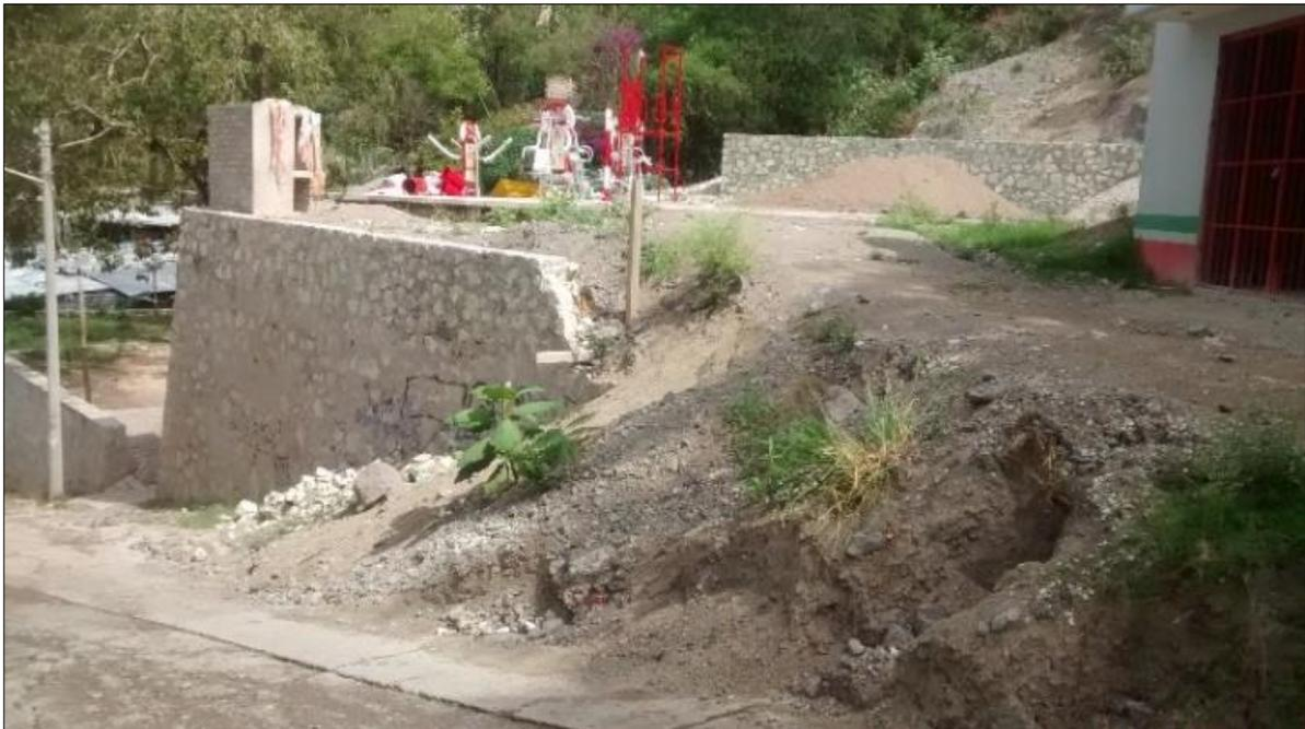
*Figuras 14.* Construcción de centro deportivo sin consideración topográfica y estudio del suelo. La obra está ubicada en una zona propensa a deslizamiento de laderas. Fuente propia, 2018.
