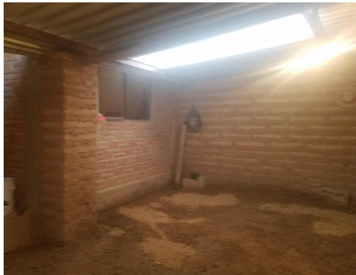
Fotografía V.4.- Cubierta de vivienda sustituida con lamina se asbesto y partes con lamina translúcida.
