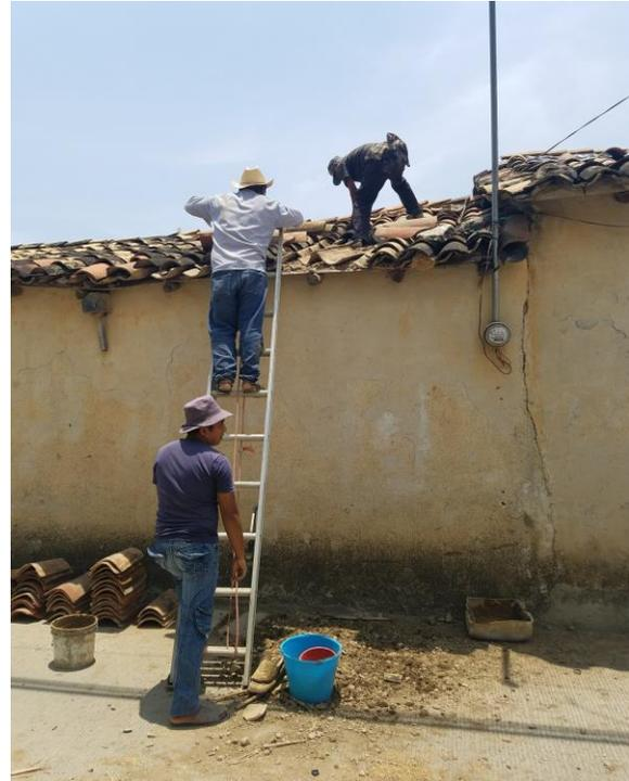
Fotografía V.5 Sustitución de cubierta de teja por materiales industrializados.
