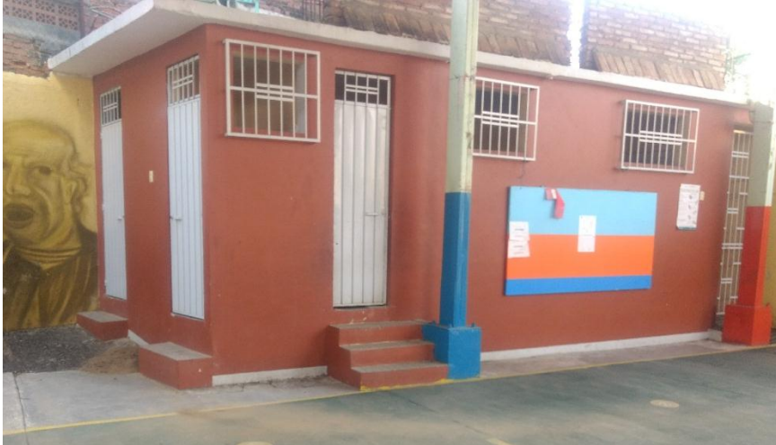
Imagen 36: Módulo de servicios sanitarios, edificio "F"
