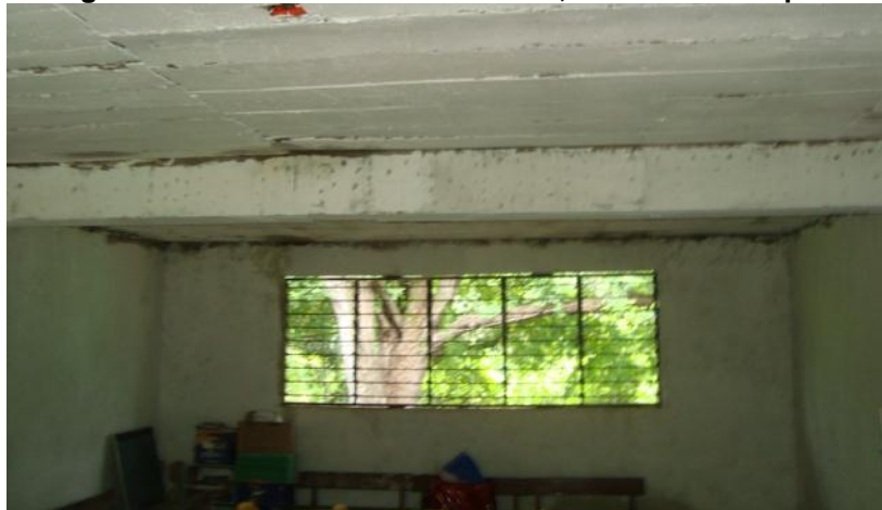
Imagen 69: Ventanas en aula didáctica, escuela de Acapulco.
