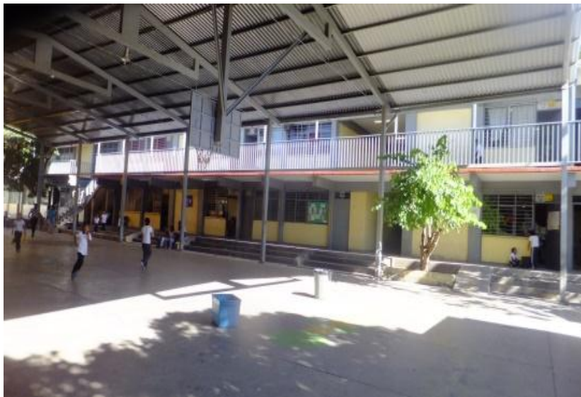
Imagen 18: Cancha de usos múltiples y edificio “A”.
