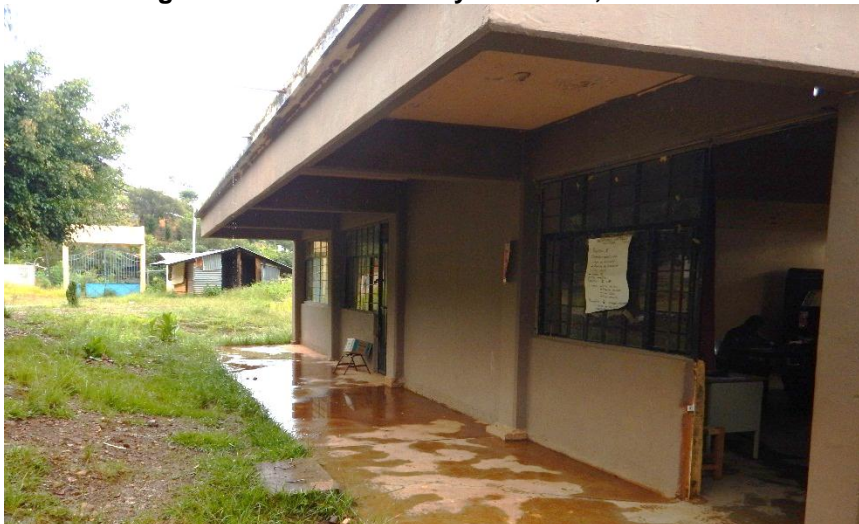
Imagen 25: Aula didáctica y dirección, edificio "A".
