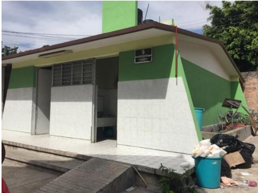
Imagen 20: Modulo de servicio sanitario, edificio “E”
