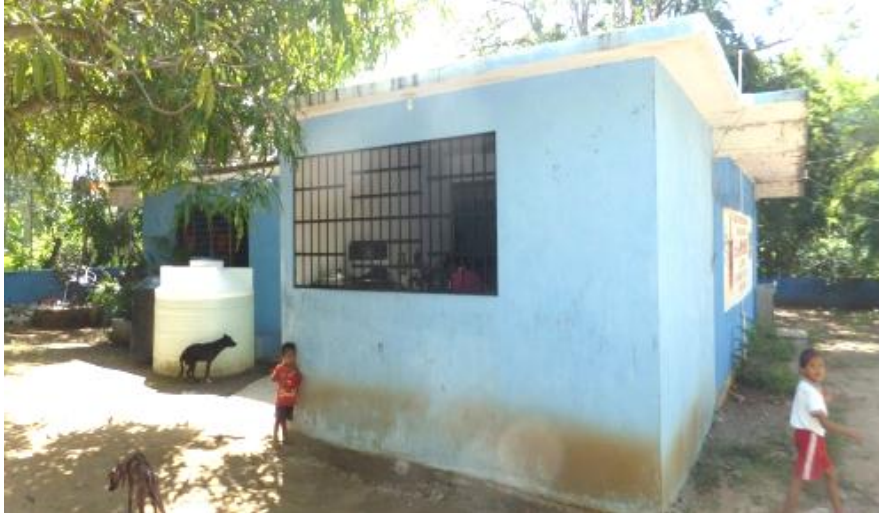
Imagen 67: Edificio “B”, escuela de la Región Norte. Aulas didácticas
