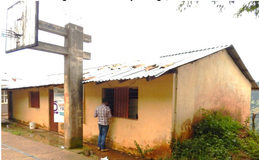
Imagen 27: Comedor y bodega, edificio "C"
