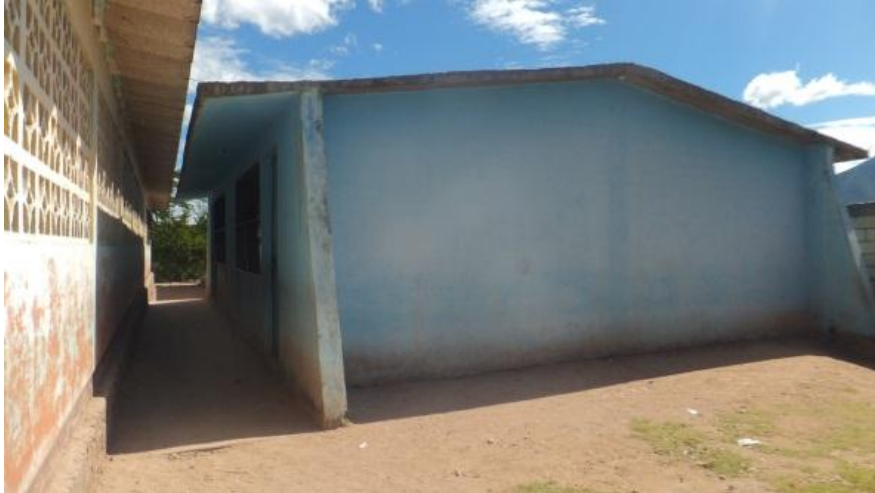
Imagen 66: Edificio “F”, escuela de la Región Norte. Aulas didácticas
