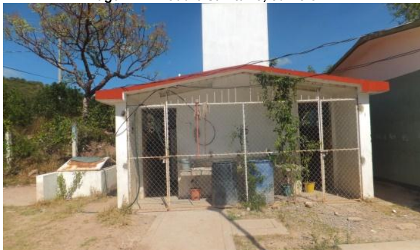
Imagen 47: Modulo sanitario, edificio “C”.
