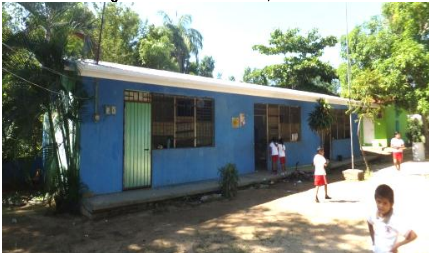
Imagen 52: Aulas didácticas, edificio “A”
