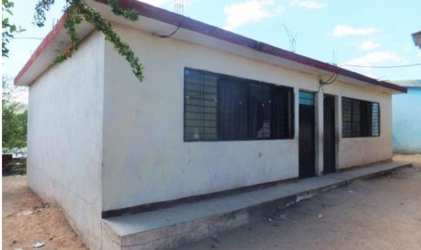
Imagen 48: Aulas didácticas, edificio “G”.
