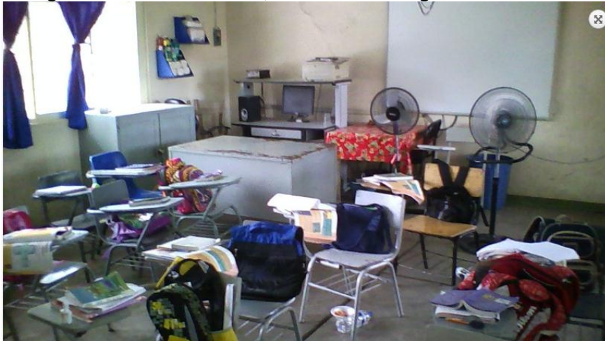
Imagen 68: Aulas didácticas, escuela en la Región Tierra Caliente.
