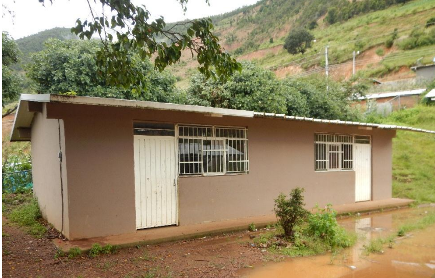
Imagen 28: Bodega, edificio "D"
