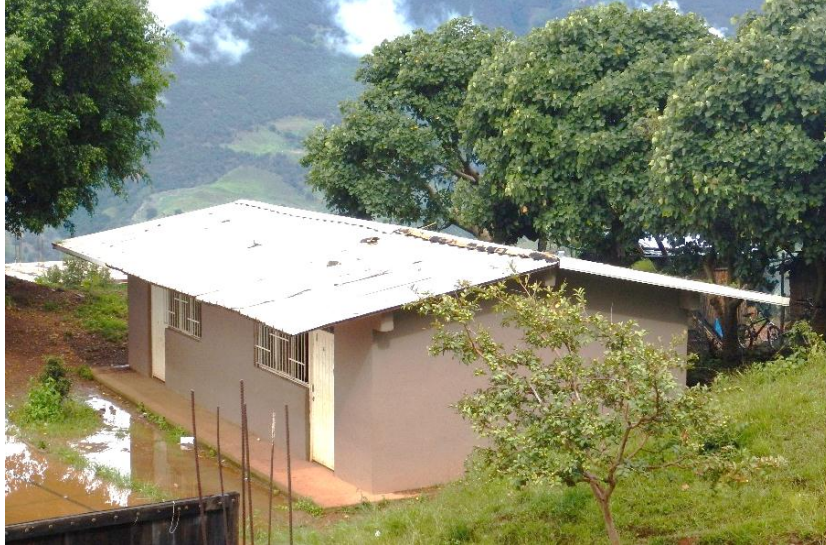
Imagen 70: Edificio “D” techado con lámina galvanizada, escuela de la Región Montaña.
