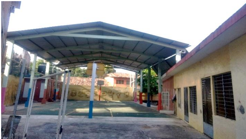
Imagen 32: Cancha de usos múltiples del plantel.
