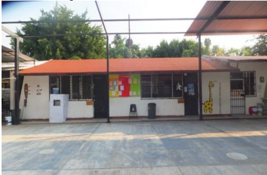
Imagen 40: Aulas didácticas, edificio “A”
