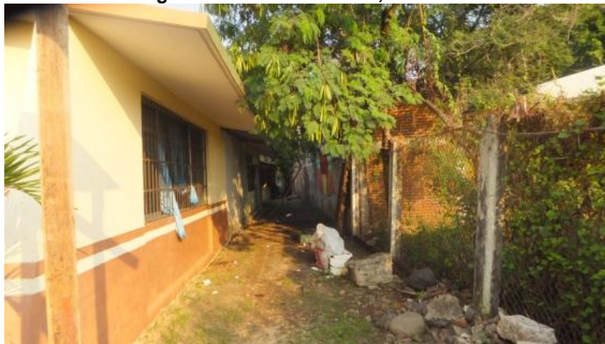
Imagen 42: Aulas didácticas, edificio “F”
