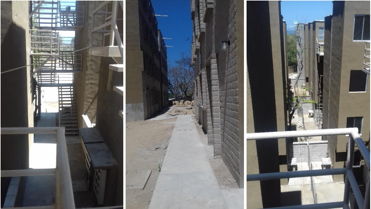
Foto 17: Creación de canales de aire con las mismas edificaciones para aprovechar la ventilación natural
