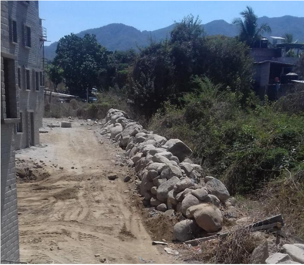
Foto 11: Material recuperado en conjunto habitacional
