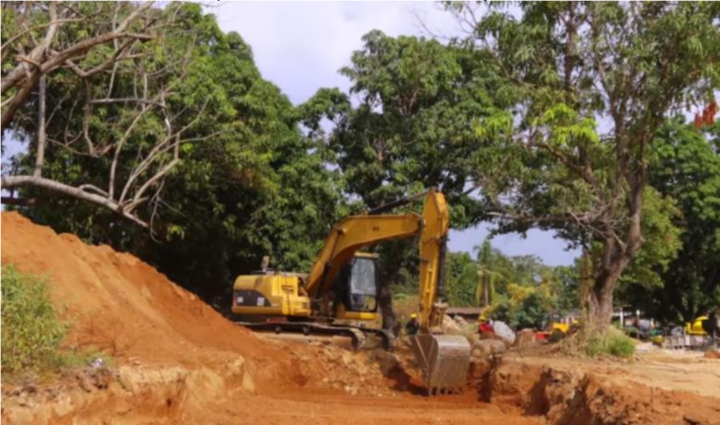
Foto 13: Extracción del tepetate dentro de la zona del conjunto habitacional
