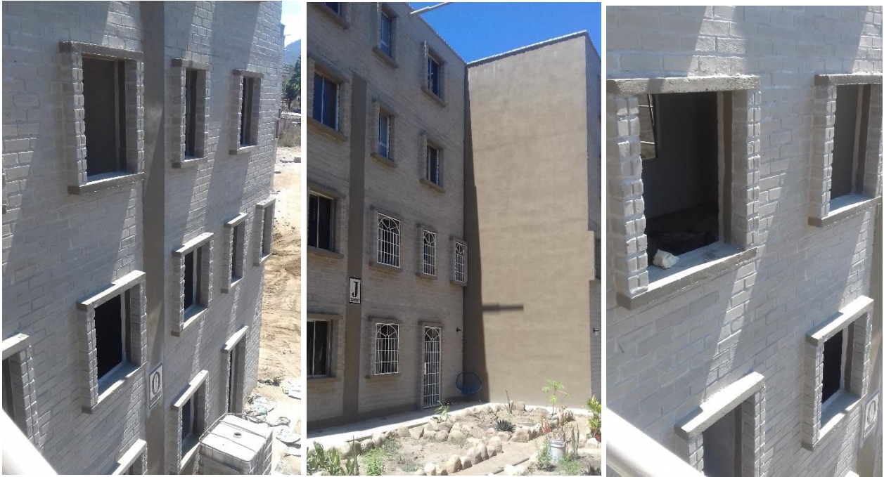
Foto 18: Aprovechamiento de la orientación y elementos arquitectónicos que evitan la radiación directa del sol en las viviendas.
