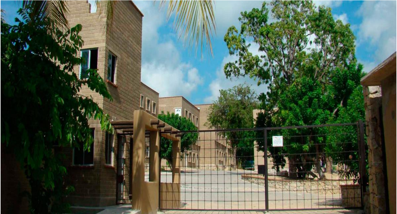
Foto 4: Entrada principal Conjunto Habitacional Pedregal de Cantaluna
