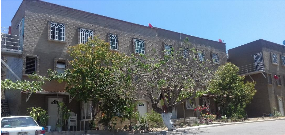
Foto 5: Fachada del prototipo de vivienda de interés social
