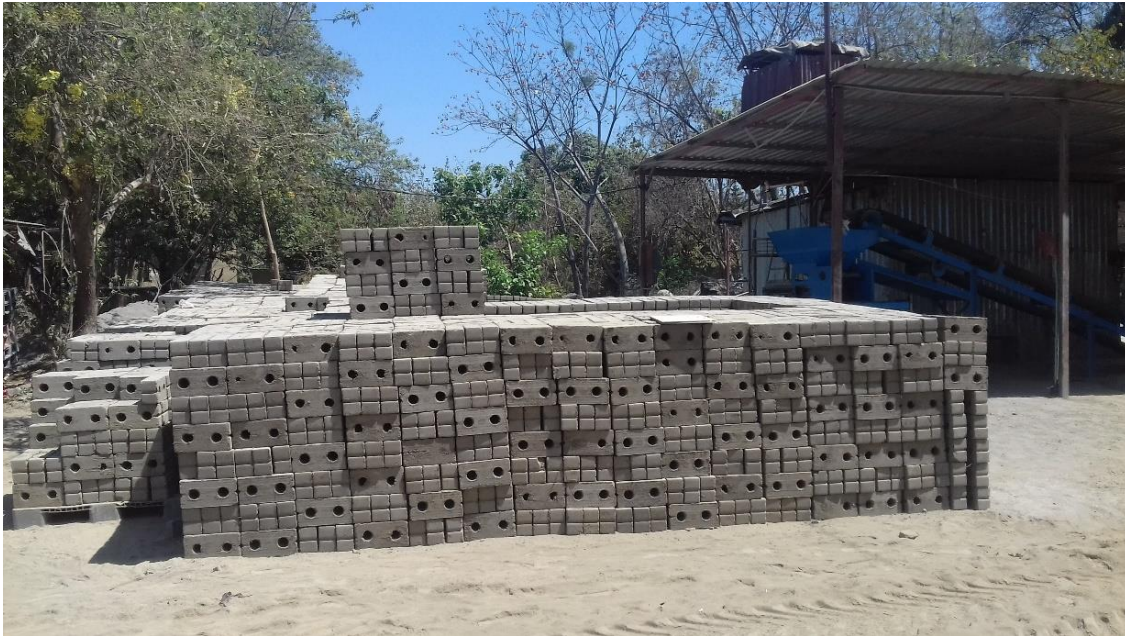
Foto 10: Producto final obtenido en la elaboración de los blocks de adobe
