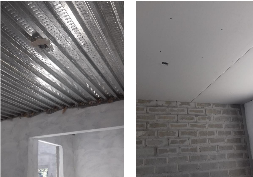
Foto 20: Uso de cubiertas termo-aislantes en la construcción de las viviendas
