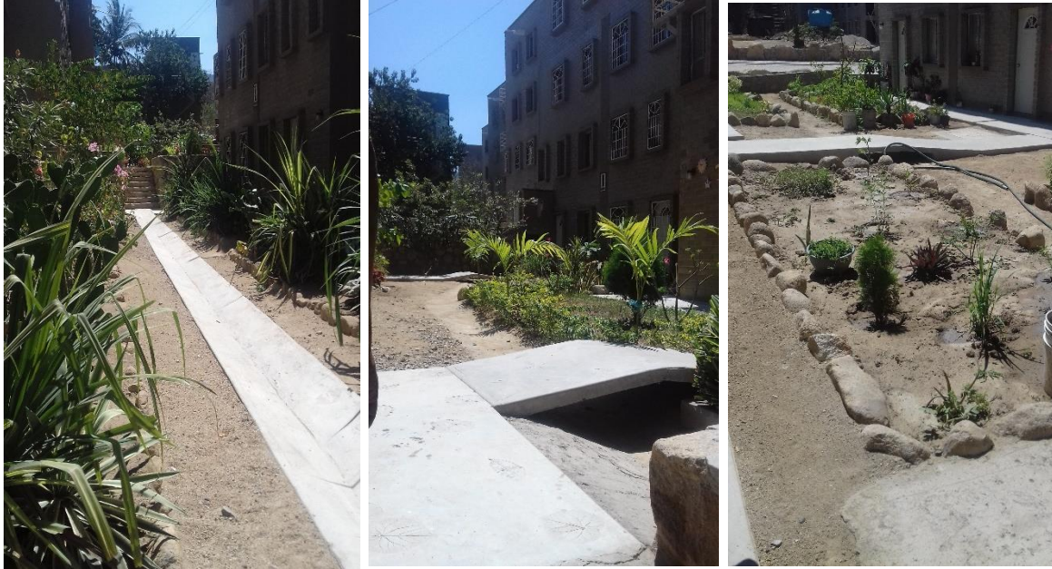
Foto 19: Canales de captación de aguas pluviales y zonas de cultivo
