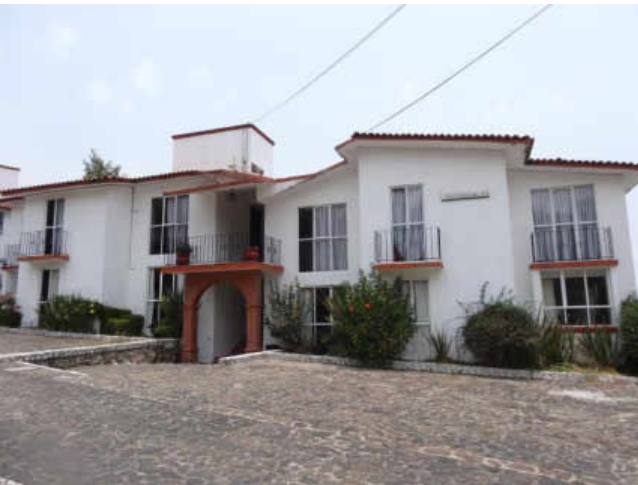
Figura 5.180. Edificio de Master Suites de Villas de la Montaña. Fuente: Elaboración propia.
