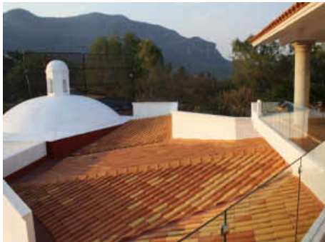
Figura 5.193. Estructura y losa a base de concreto armado, cubierta con teja industrializada en Hotel De Cantera y Plata. Fuente: Elaboración propia .
