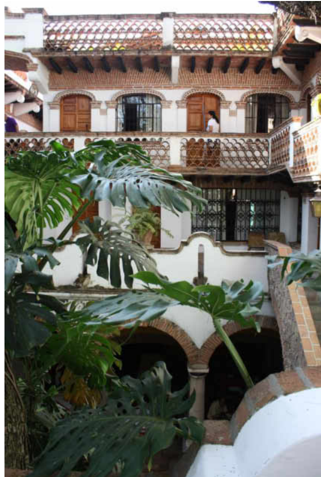
Figura 3.10. Hotel Los Arcos. Fuente: Elaboración propia.
