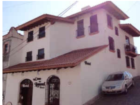
Figura 5.194. Estructura y losa a base de concreto armado, Herrería, y cubierta con teja industrializada en Hotel La Casa del Laurel. Fuente: Jaimes, Y. y Pastrana, E.
