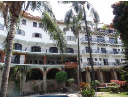
Figura 4.73. Hotel Posada San Javier. Fuente: Elaboración propia.
