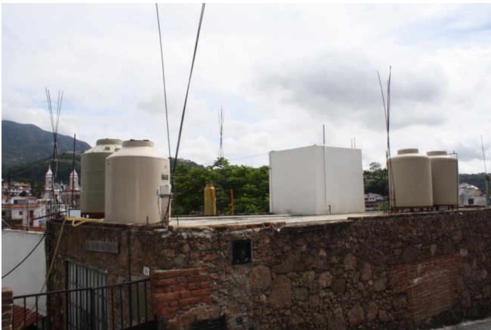
Figura 6.22. Tinacos y tendederos en azoteas, la quinta fachada. Fuente: Elaboración propia.
