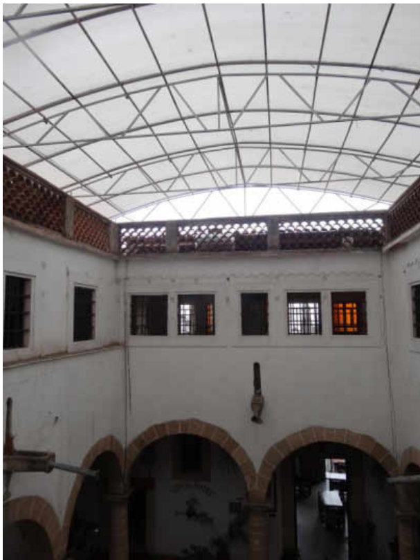
Figura 6.5. Material industrializado en techos. Fuente: Elaboración propia.
