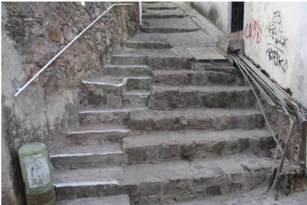
Figura 6.25. Tubería hidráulica y sanitaria visible en callejón de Taxco. Fuente: Elaboración propia.
