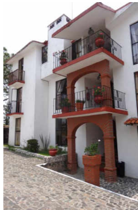
Figura 5.197. Estructura y losa a base de concreto armado y Herrería en puertas y ventanas, en Villas de la Montaña. Fuente: Elaboración propia .
