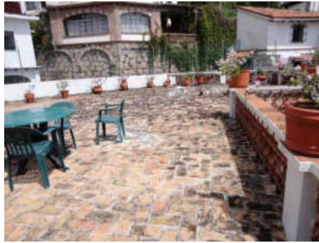
Figura 5.188. Losa plana con petatillo en Hotel Agua Escondida. Fuente: Jaimes, Y. y Pastrana, E.
