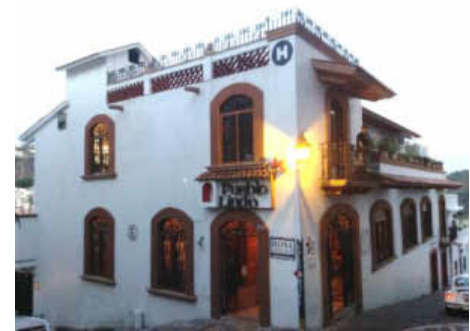
Figura 4.135. Fachada del Hotel Pueblo Lindo. Fuente: Cabañas, E., Figueroa, L. y Rodríguez, L.
