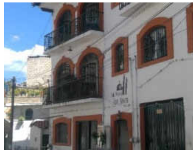
Fachada del hotel San Juan. Fuente: Caballero, Samuel.
