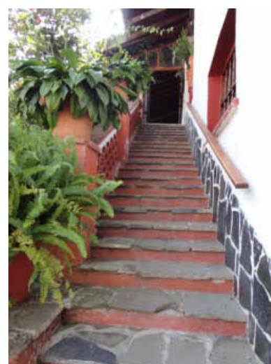
Fig. 3.68. Escaleras. Fuente: Elaboración propia.
