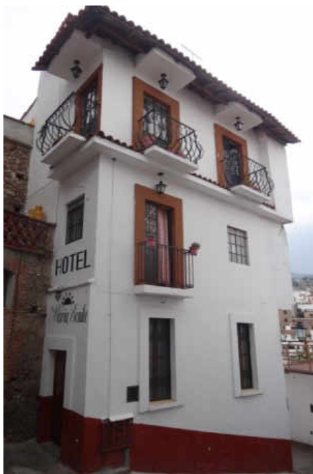
Figura 5.196. Estructura y losa a base de concreto armado, Herrería, y cubierta con teja industrializada en Hotel María Bonita. Fuente: Elaboración propia .
