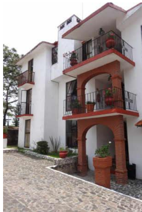
Figura 5.66. Edificio de Villas de la Montaña. Fuente: Elaboración propia.
