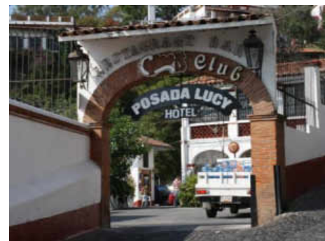
Figura 5.72. Acceso Hotel posada Lucy. Fuente: Elaboración propia.
