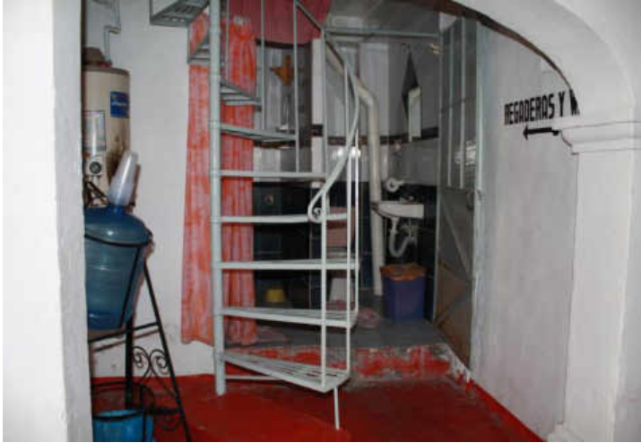
Figura 5.3. Regaderas y sanitarios comunes en la Casa de Huéspedes la Central. Fuente: Elaboración propia.
