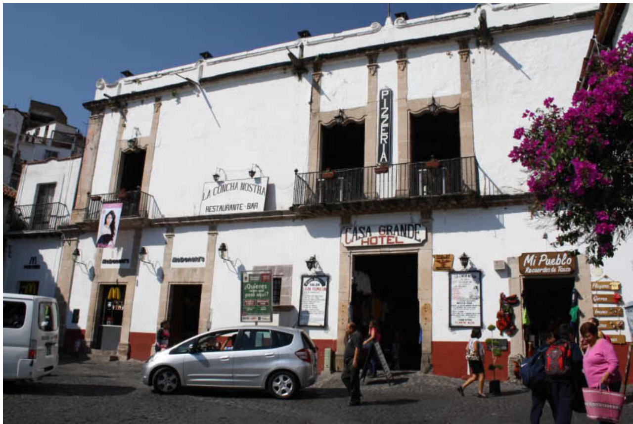
Figura 3.19. Fachada actual del hotel Casa Grande. Fuente: Elaboración propia .
