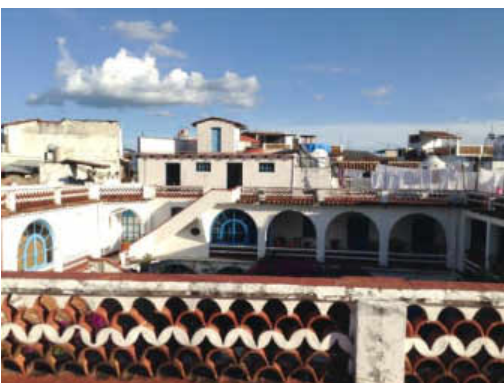
Figura 5.170. Bodega general y área de tendederos del Hotel Santa Prisca. Fuente: Cabañas, E., Figueroa, L. y Rodríguez, L.
