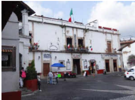
Figura 4.86. Hotel Casa Grande. Fuente: Elaboración propia.
