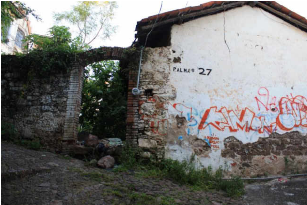
Figura 6.21. Construcción abandonada, en inmediaciones del centro histórico. Fuente: Elaboración propia.
