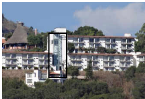
Figura 5.206. Elevador del Hotel Monte Taxco. Fuente: Elaboración propia.
