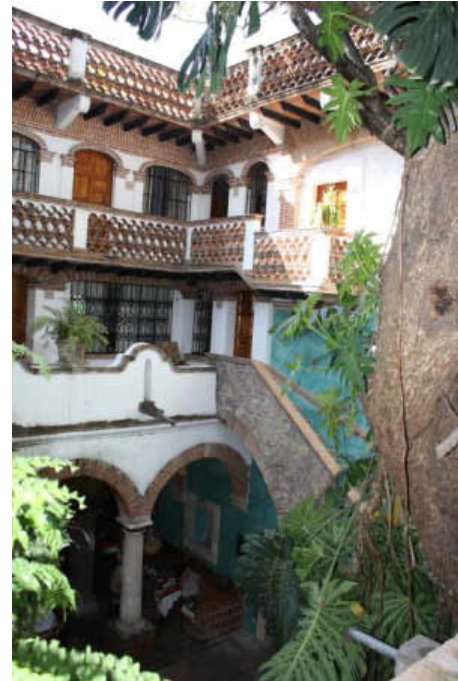
Figura 5.151. Panorama del Patio central del Hotel Los Arcos. Fuente: Elaboración propia.
