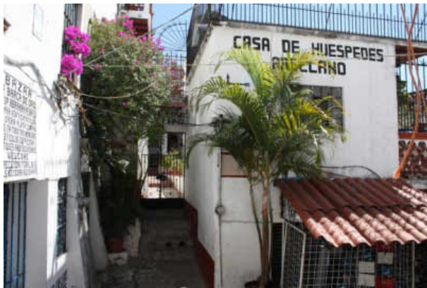
Fig. 3.72. Acceso de la C. de H. Arellano. Fuente: Elaboración propia.
