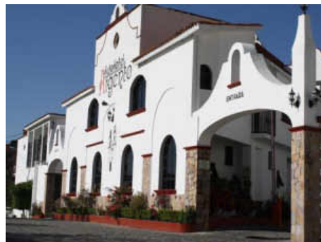
Figura 5.71. Acceso Auto hotel Argentos. Fuente: Elaboración propia.
