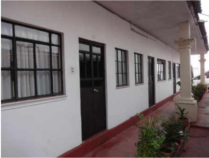
Figura 3.12 Cuartos en segundo nivel. Fuente: Elaboración propia.
