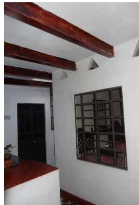
Figura 5.198. Estructura a base de vigas de acero de perfil I, en Hotel Casa Grande. Fuente: Elaboración propia .
