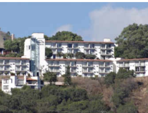
Figura 5.201. Edificio de habitaciones en Hotel Monte Taxco. Fuente: Elaboración propia.
