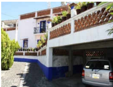
Estacionamiento de Bungalows Millán (Vista Alegre). Fuente: Elaboración propia.
