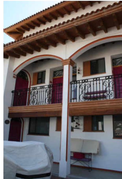
Figura 5.195 Estructura y losa a base de concreto armado, Herrería, y cubierta con teja industrializada en Hotel Pueblo Lindo Fuente: Elaboración propia .
