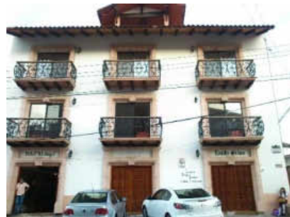
Fachada del hotel El Ángel. Fuente: Cabañas, E., Figueroa, L. y Rodríguez, L.
