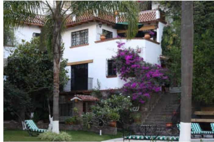
Figura 4.29. Departamento en Posada de San Javier. Fuente: Elaboración propia.
