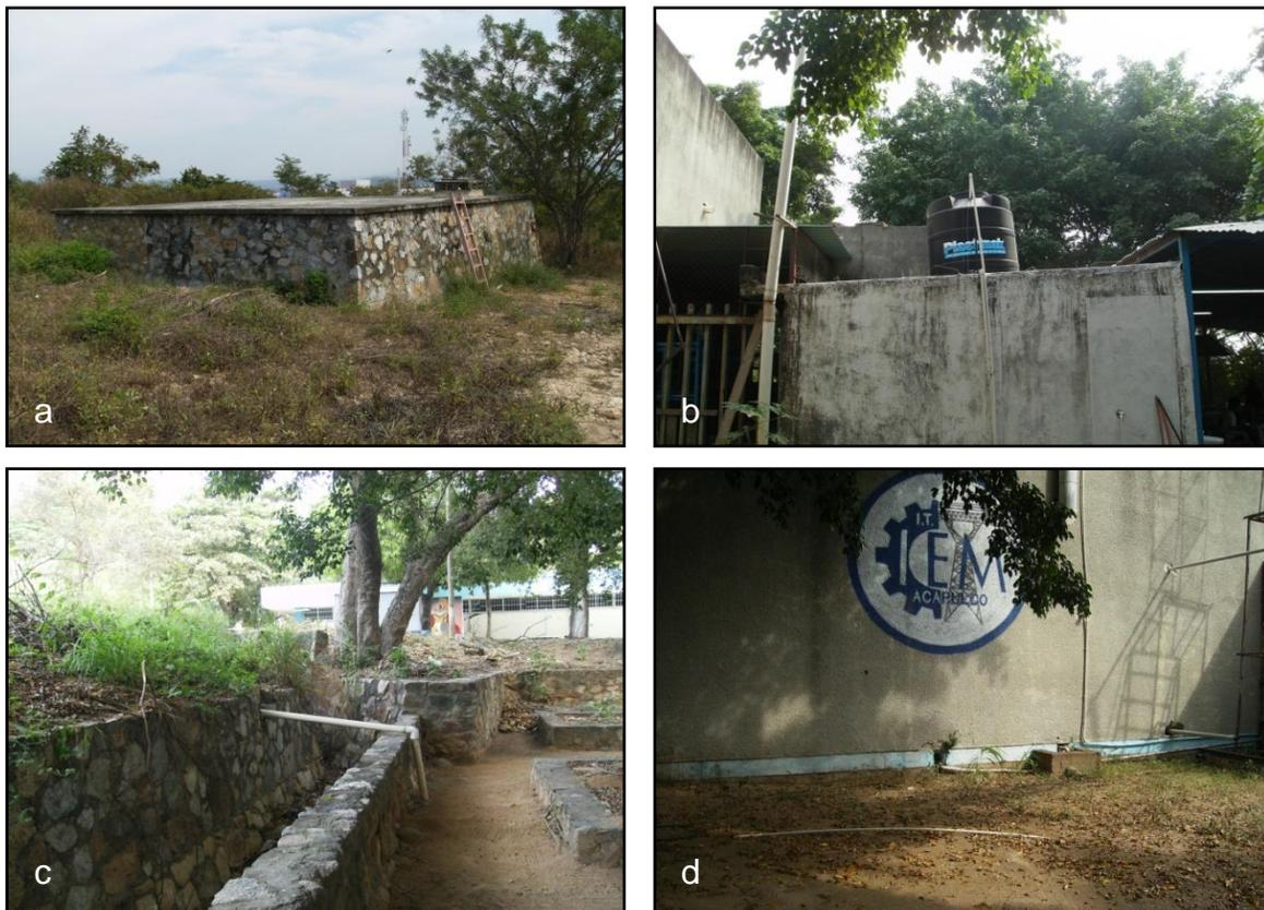
**Figura 11.** Abastecimiento de agua potable en el ITA. a) Tanque de mampostería, b) Tanque elevado en cada edificio, c) Tuberías de distribución, d) Conexiones improvisadas de tuberías.
