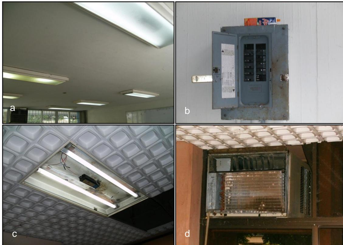
**Figura 12.** Instalaciones eléctricas en el ITA. a) Lámparas encendidas innecesariamente, b) Tableros de control sin protección, c) Lámparas descubiertas y balaustas en malas condiciones, d) Equipos viejos y obsoletos de aire acondicionado.
