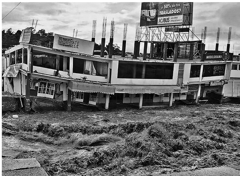
Imagen 6. Desbordamiento del río Huacapa en Chilpancingo, 15 de septiembre de 2013.
