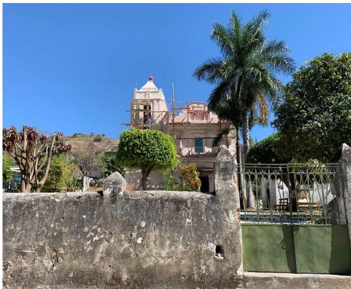
Figura 11. Iglesia de Atzala. Fuente: Propia, 2019.
