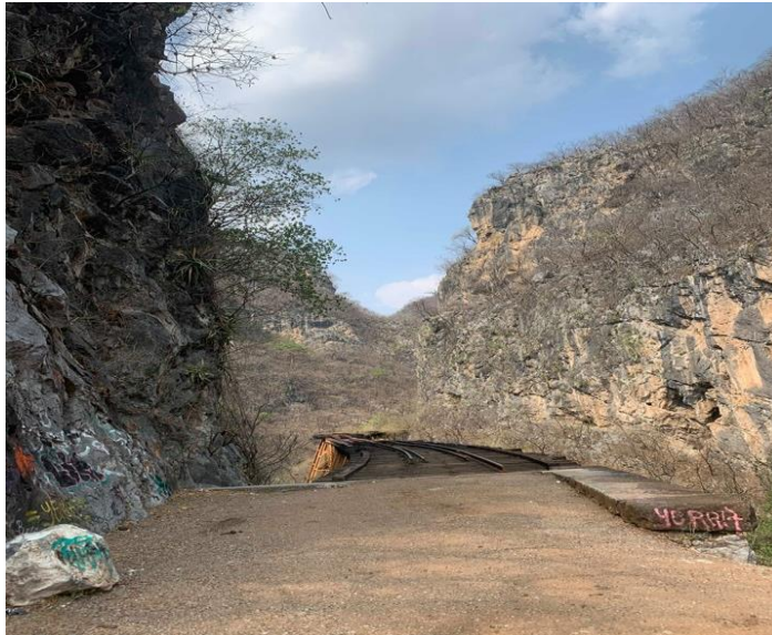
Figura 18. Puente de la mano, El Naranjo. Fuente: Propia, 2019.
