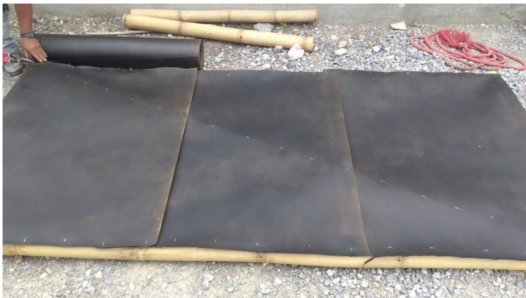
Figura 3.1.9. Colocación del Cartón en el bastidor.
