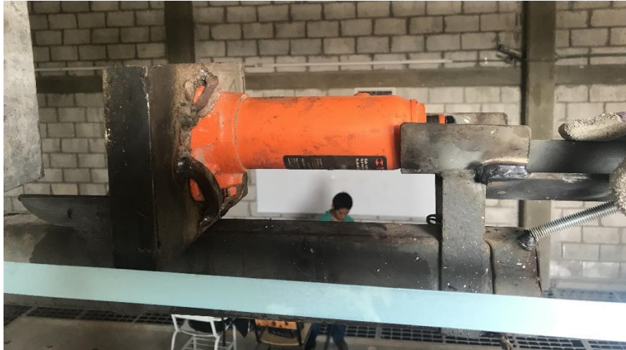
Figura 3.2.11 Colocación de gato hidráulico para la aplicación de la carga lateral.
