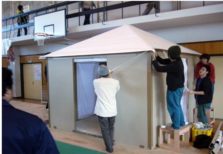
Figura 1.3.5 Panel de armado con tubos de cartón
