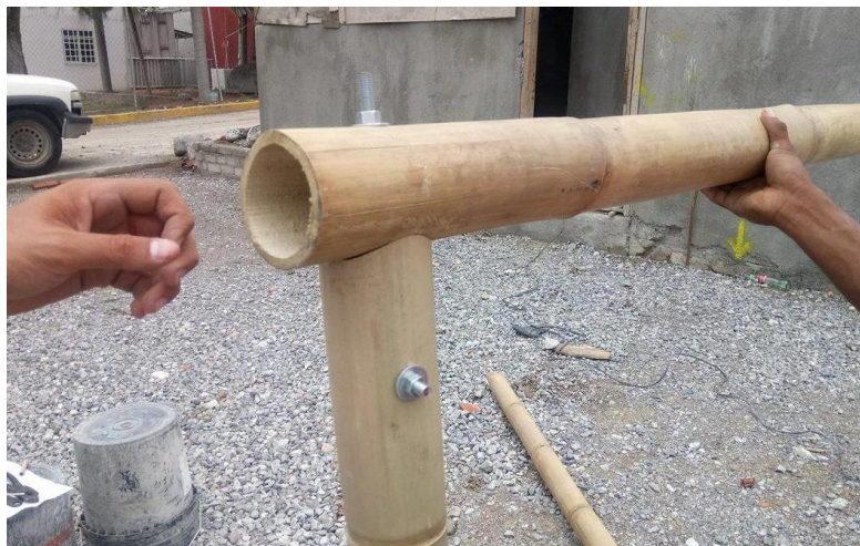
Figura 23. Esquina terminada y ensamblada con pernos.
