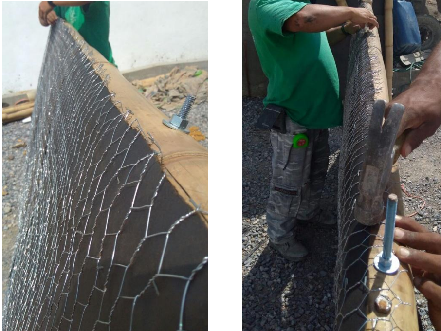
Fig. 3.1.11 Ajuste de malla hexagonal a los costados del módulo
