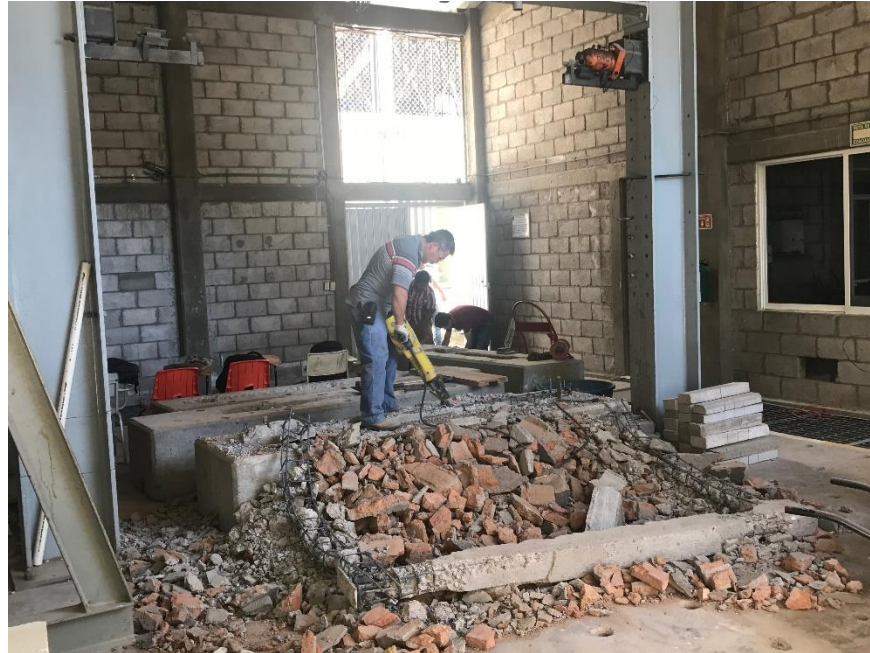
Figura 3.2.1 Muerto de concreto en laboratorio de materiales
