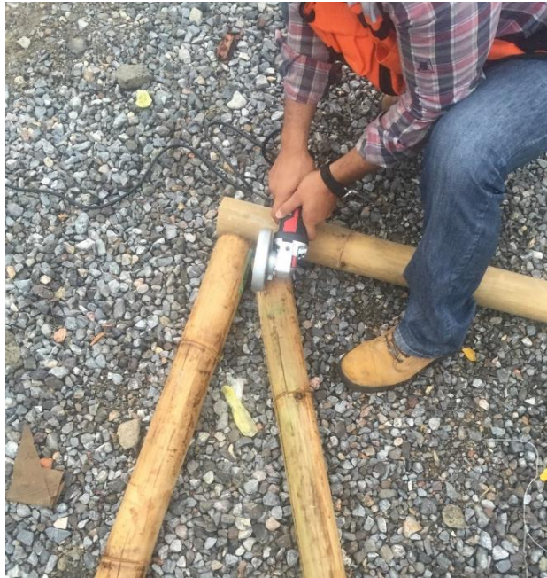
Figura 3.1.5 Corte pico de flauta en bastidores.
