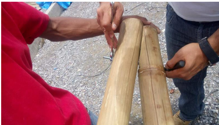
Figura 3.1.7 Ensamble de contrafuerte con pico de flauta en bastidor
