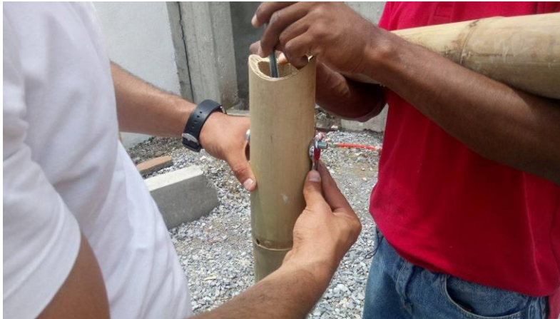
Figura 3.1.2 Colocación de pernos
