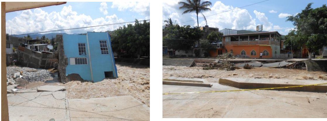
Figura 1.1.1 Estragos ocasionados por la tormenta tropical Manuel en Chilpancingo, Septiembre del 2013.
