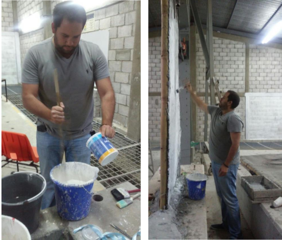
Figura 3.2.5 Mezcla de sellador, cal y agua
