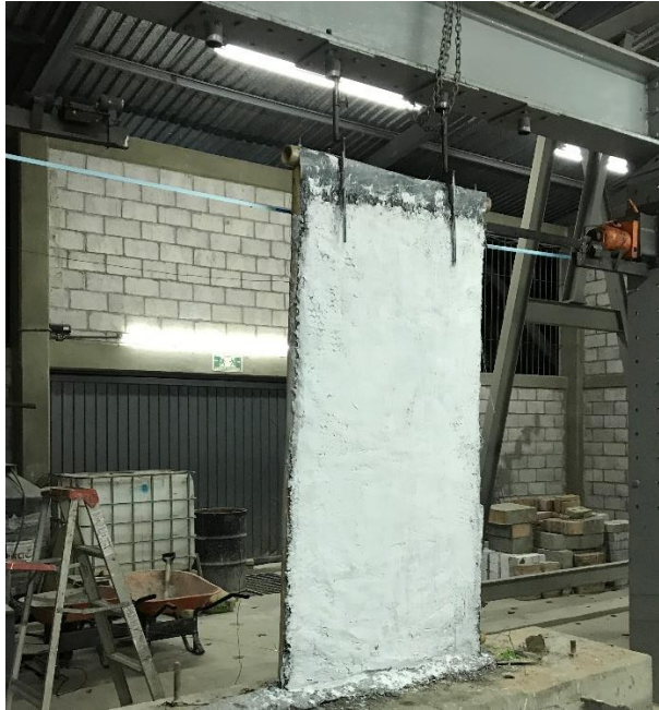
Figura 3.2.6 Muro pintado de blanco
