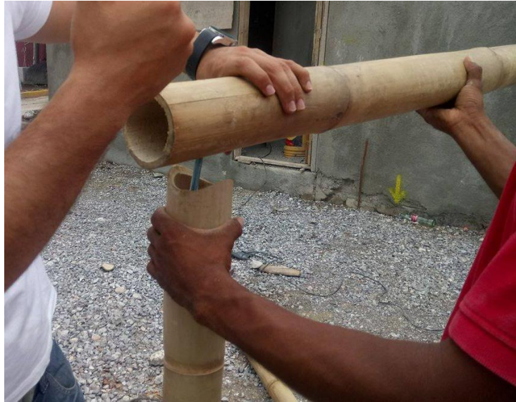
Figura 3.1.3 Inserción del travesaño
