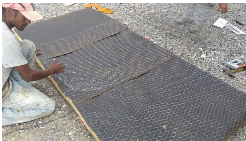
Figura 3.1.10 Colocación de malla hexagonal Cal. 20
