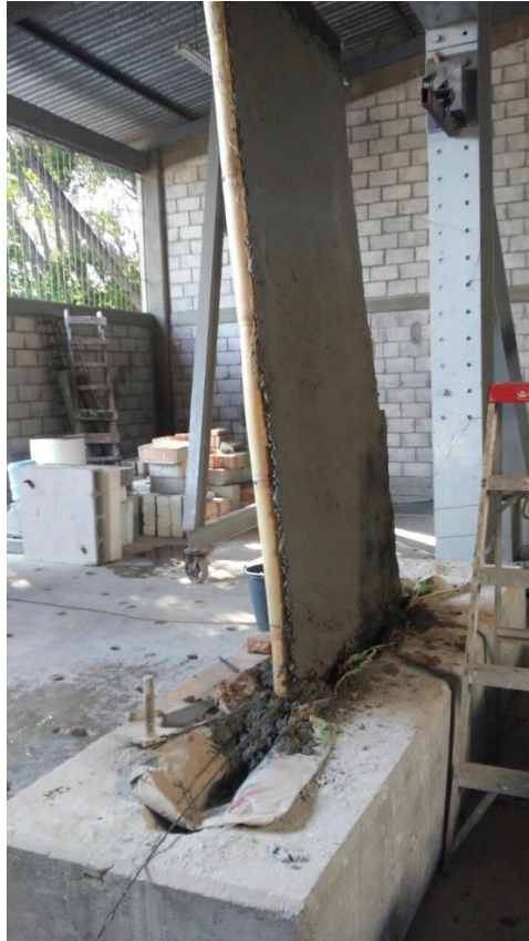
Figura 3.2.4 Aplanado de muro y colocación de concreto en la base.
