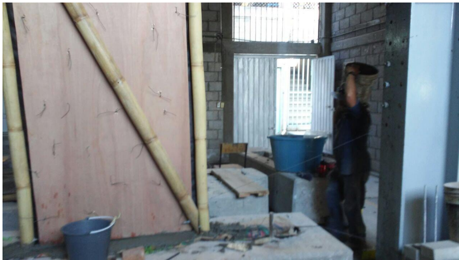
Figura 3.2.3. Cimbra con triplay al muro.
