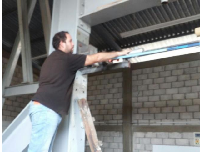
Figura 3.2.13 Colocación de celda de carga en la estructura.
