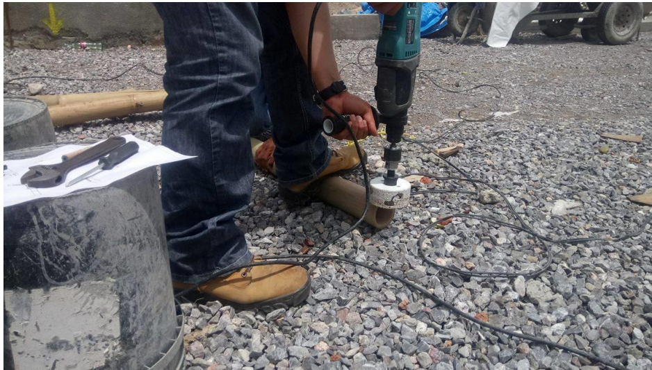
Figura 3.1.1 Corte Boca de pescado
