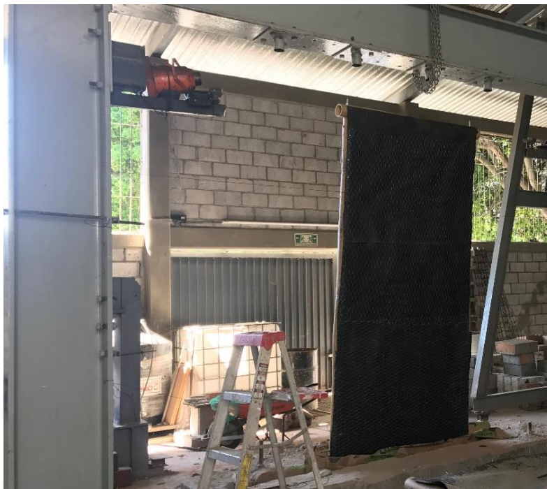
Figura 3.2.2 Colocación de muro sobre muerto de concreto.
