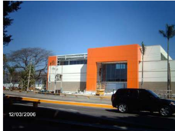
Imagen 91.- Construcción del Centro de Autoservicio ubicado en el acceso de la U.H. Luis D. Colosio en el 2006. Foto: Manuel Ruz
