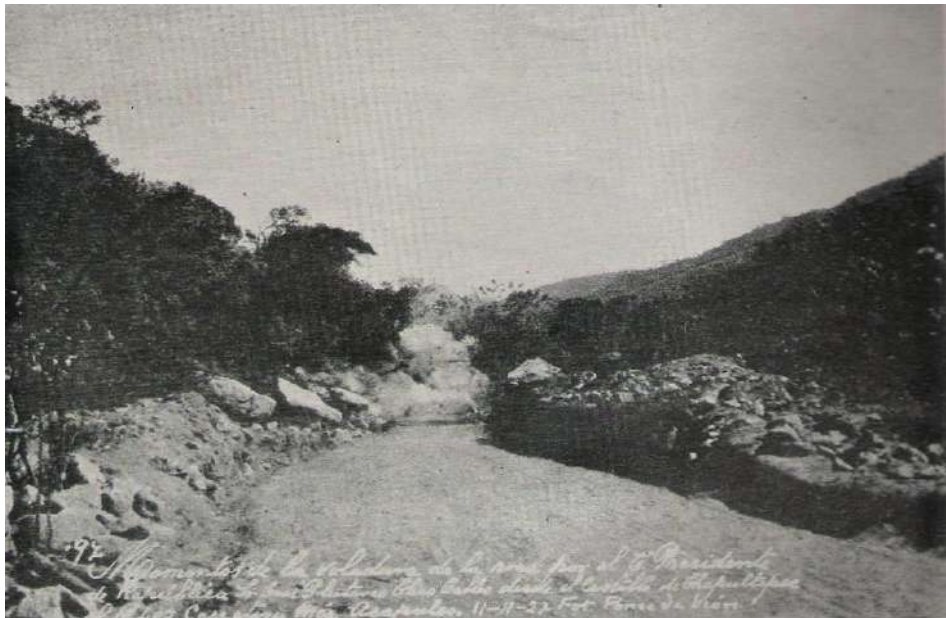
Imagen 9.- Voladura de la piedra que obstruía el camino México-Acapulco, 21 noviembre de 1927. Fuente: Archivo fotográfico de la familia Pintos
