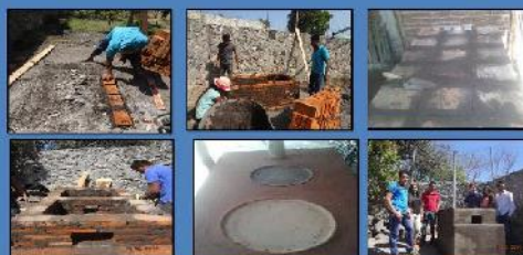
Figura 1. Construcción de la estufa ahorradora de leña.
