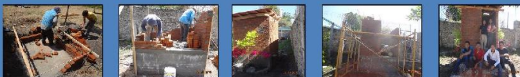
Figura 2. Construcción del baño seco
