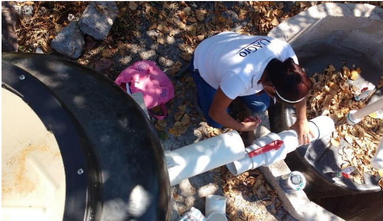
4. Pegado de las partes del Biodigestor regido DM1®
