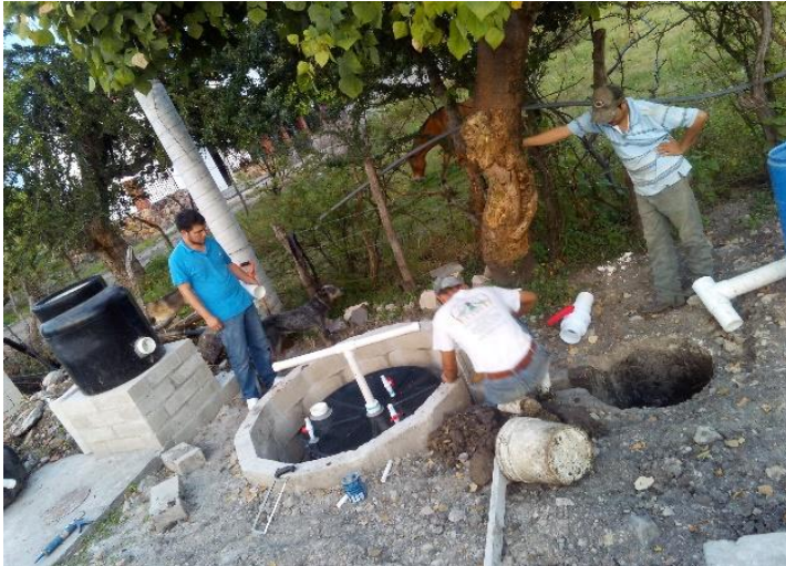
3. Instalación del Biodigestor rígido DM1®
