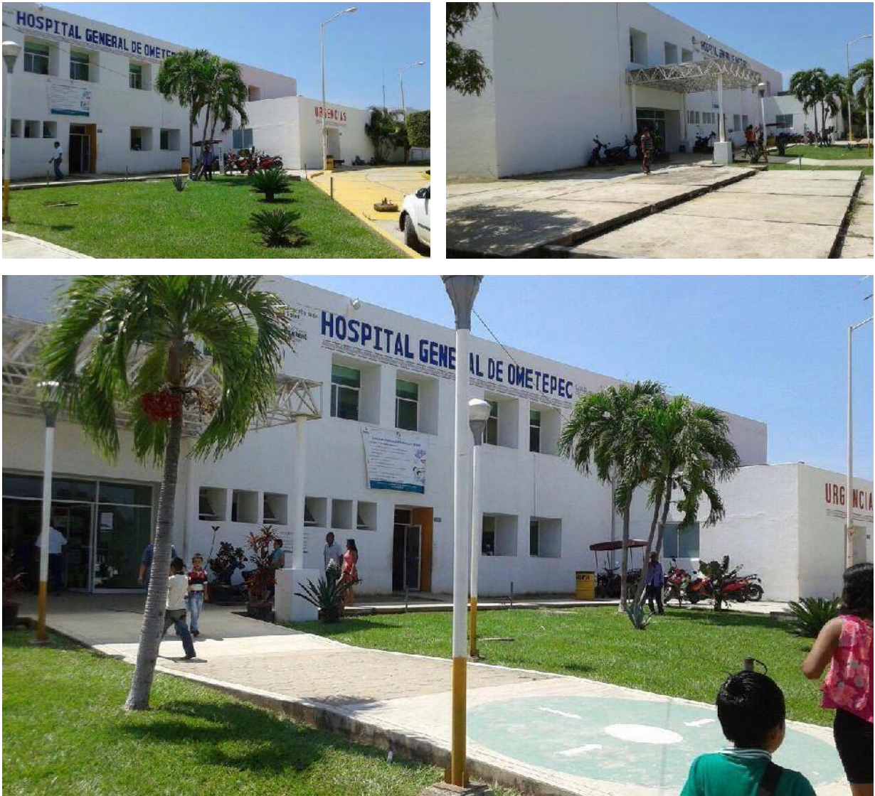
4.35, 4.36 y 4.37 . Vista del Exterior del Hospital General de Ometepec. Fuente: Archivo personal (2015).
