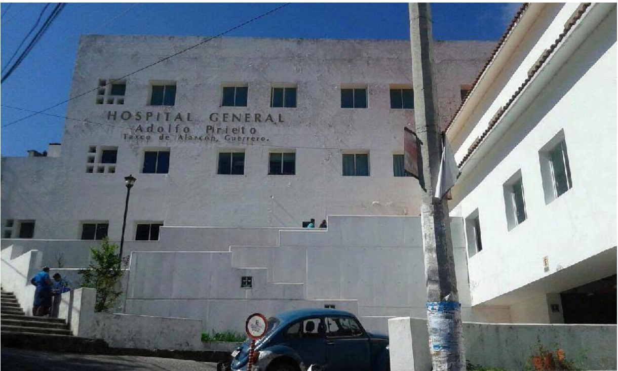
4.23. Vista del Exterior del Hospital General de Taxco. Fuente: Archivo personal (2015).
