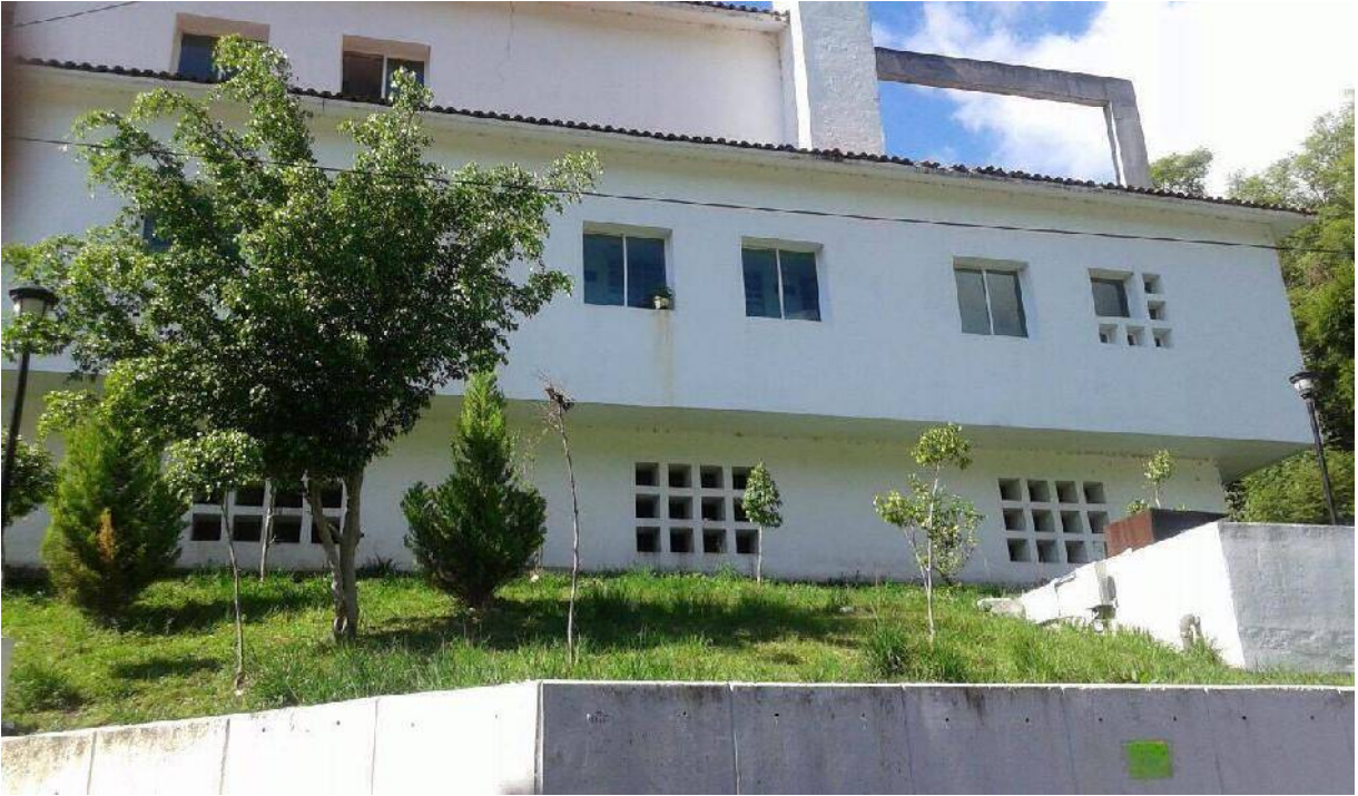
4.22. Vistas de la fachada principal del Hospital General de Taxco. Fuente: Archivo personal (2015).
