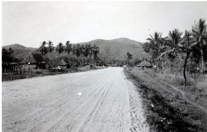
Figura 14. Camino de terracería de Acapulco. Fuente: México en fotos, 2018.
