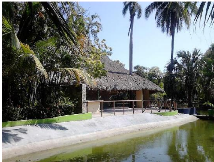
Figura 58. Restaurant del Lago. Arq. Jaime Crofton Yáñez, 1980. Fuente: Propia, 2019.
