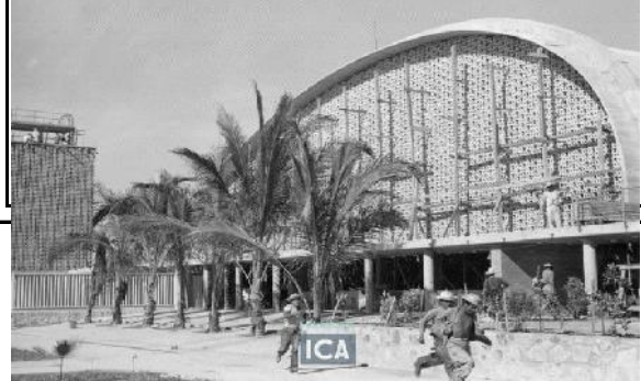
Aeropuerto en construcción. Fuente: twitter.com
