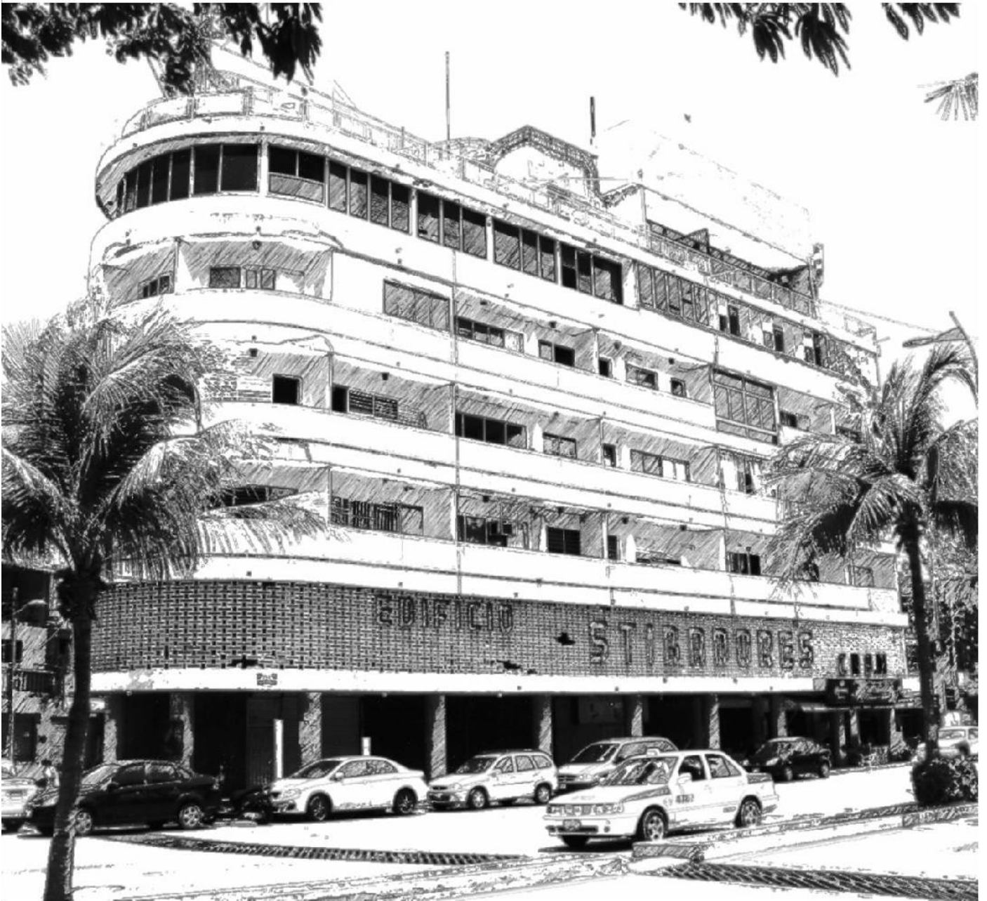
Figura 21: Edificio Estibadores. Arqs. L. Fernández y Enrique Molina, 1954. Fuente: propia, 2019.
