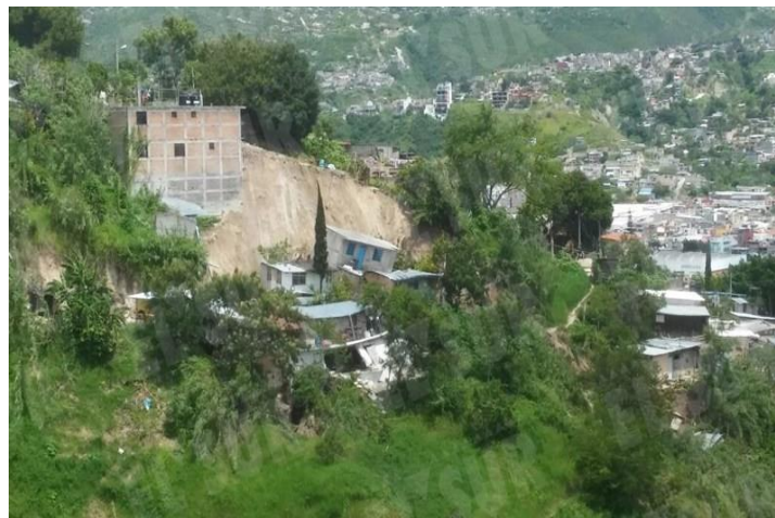
Imagen 45. Vista de la afectación que dejó el deslizamiento en la zona
