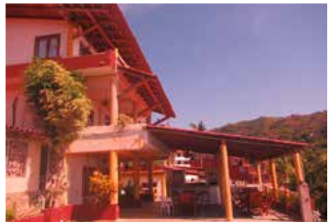
Figura 5.109 Habitaciones con terraza en Bungalows La Madera . Fuente: Archivo personal.
