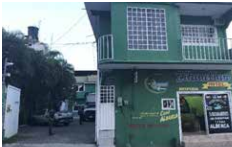
Figura 5.33 Estacionamiento y patio común en hotel Zihuatlan . Fuente Archivo personal.
