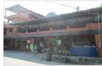
Fachada del hotel. Fuente: D. G. Adame, D. Leonardo y B. Rivera.
