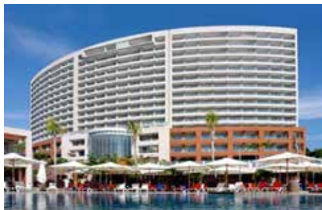
Figura 5.47 Edificio de habitaciones de 17 niveles del hotel Azul Grand Ixtapa . Fuente Reserve Online. 2021. Recuperado de https://reserveonline.travel/hoteles/ixtapa-zihuatanejo/hotel-azul-ixtapa-grand-all-suites-spa-and-convention-center/
