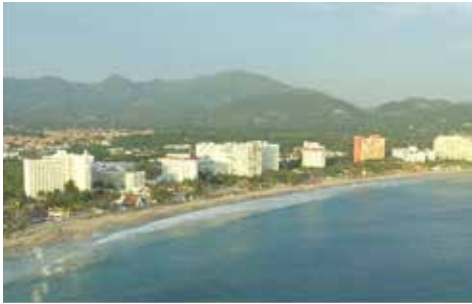
Figura 6.81. Hoteles en franja de playa del CIP Ixtapa, construidos principalmente a base de estructura de concreto armado, y materiales industrializados. Fuente: M. Ángel Quirino.
