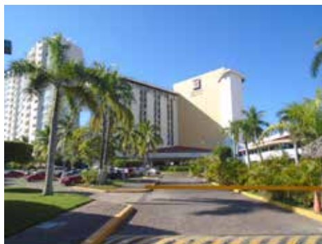
Figura 5.50 Edificio de 10 niveles en hotel Krystal Ixtapa . Fuente M. Ángel Quirino.
