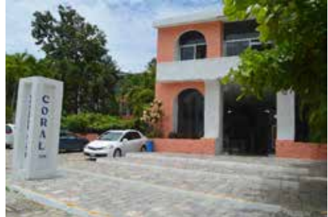
Figura 5.102 Uso de vanos rectos y arco de medio punto en edificio principal del hotel Coral Ixtapa . Fuente: M. Ángel Quirino.
