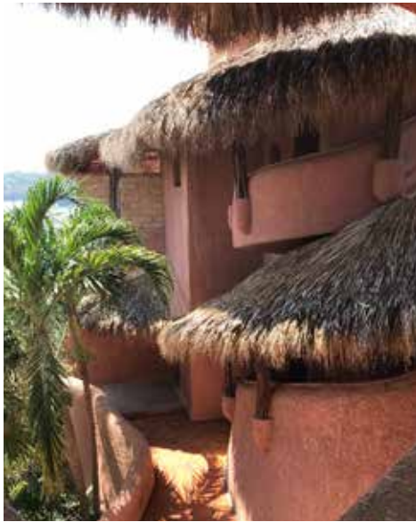
Figura 5.59 Techos inclinados en hotel La Casa Que Canta . Fuente: Natalia Ocampo.
