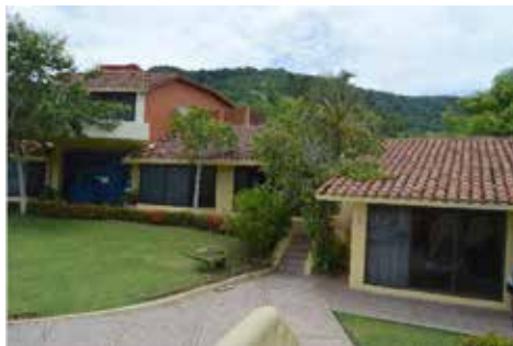
Figura 5.68 Uso de techos inclinados en hotel Coral Vista del Mar . Fuente: M. Ángel Quirino.
