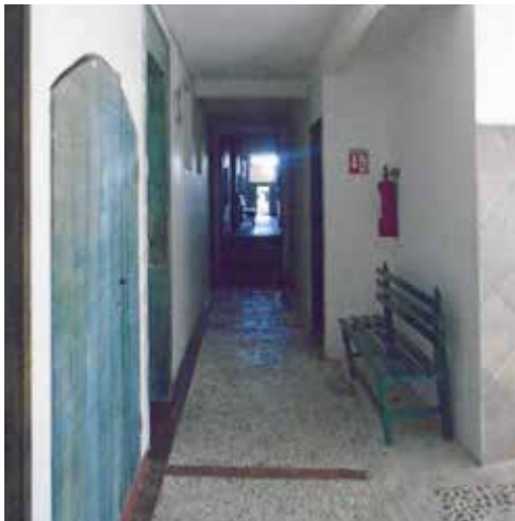
Figura 6.89. Extinguidor situado en pasillo de habitaciones del hotel Zihuatanejo Centro . Fuente: A. G. Melo y L. F. Moctezuma.
