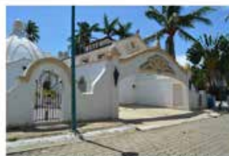
Acceso del hotel Casa de Los Espejos. Fuente: M. Ángel Quirino.
