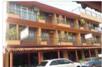
Fachada principal de hotel Raúl 3 Marias Centro. Fuente: B. Bárcenas y D. Díaz.
