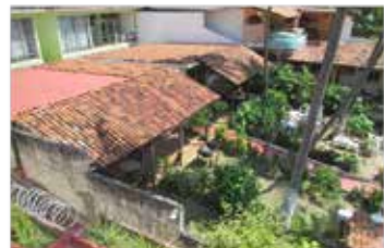
Edificio de habitaciones. Fuente: Archivo personal.
