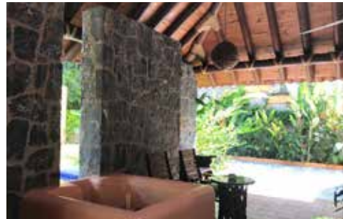
Figura 6.84. Techos de madera con muros de piedra y tabique en hotel Casa Don Francisco . Fuente: Archivo personal.
