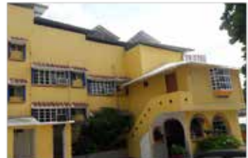
Edificio de habitaciones del hotel Bahía. Fuente: B. Barcenas y D. Diaz.
