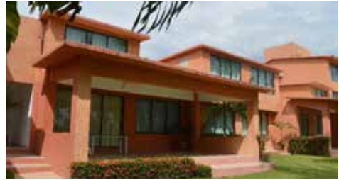
Figura 5.96 Uso de vanos rectos en puertas y ventanas en hotel Quinta Ixtapa . Fuente: M. Ángel Quirino.
