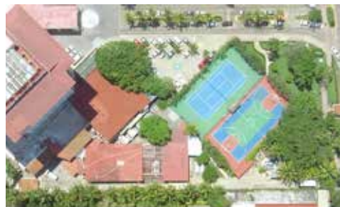
Figura 6.68. Cancha multiusos y cancha de tenis en hotel Emporio Ixtapa . Fuente: M. Ángel Quirino.
