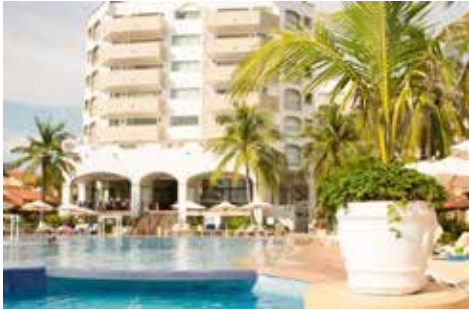
Figura 5.103 Uso de vanos rectos y redondeados en hotel Tesoro Resort Ixtapa . Fuente: Aca Reservas Ixtapa. 2021. Recuperado de https://www.acareservasixtapa.com/wp-content/uploads/2018/12/hotel-tesoro-ixtapa-fotos-comentarios-videos-702.jpg
