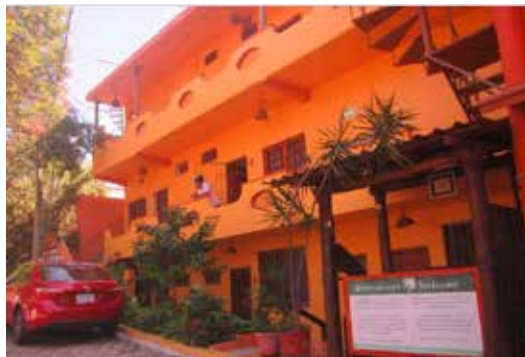
Figura 5.1. Fachada del hotel Casa Adriana . Fuente: Archivo personal.
