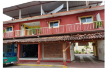
Fachada principal del hotel Conchita de Mar. Fuente: R. Flores, E. Z. Guillen y J. A. Pérez.
