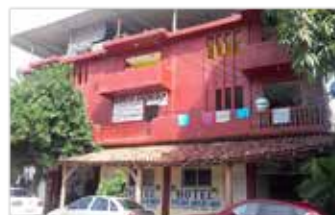
Fachada principal del hotel. Fuente: O. Cruz y J. de D. Rosas.
