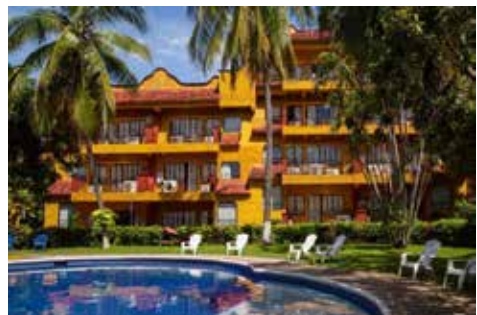
Figura 5.100 Hotel Puerta del Mar donde se aprecia el uso de vanos redondeados en puertas y ventanas. Fuente: Gites.fr. 2021. Recuperado de https://q-xx.bstatic.com/images/hotel/max1024x768/283/283226682.jpg
