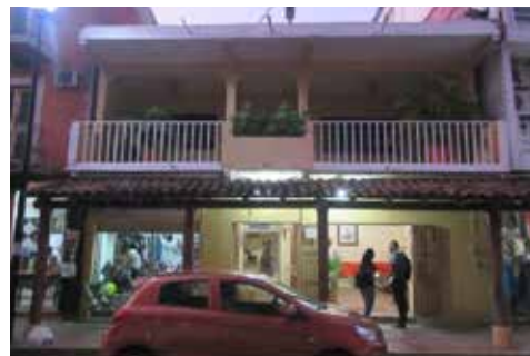
Figura 5.18. Fachada del hotel Casa Aurora en donde se observa un local comercial. Fuente: Archivo personal.
