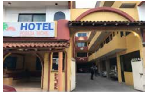
Figura 5.38 Zona patio central y estacionamiento hotel Posada Michel . Fuente Archivo personal.
