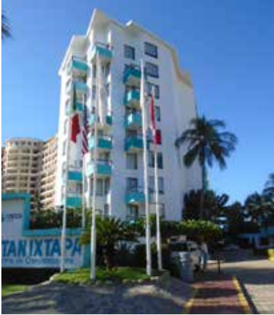
Figura 5.95 Hotel Fontan Ixtapa con la implementación de vanos rectos en puertas y ventanas. Fuente: M. Ángel Quirino.
