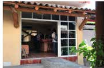
Acceso y recepción del hotel Lumon. Fuente: Natalia Ocampo.
