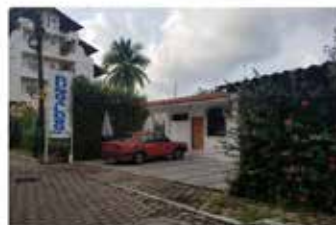
Acceso a bungalows Camila. Fuente: I. Y. Camilo y D. A. Mendoza.
