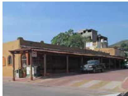
Fachada del hotel Estrellita de Jesús . Fuente: D. G. Adame, D. Leonardo y B. Rivera.
