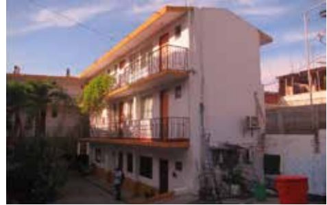
Figura 5.58 Edificio de habitaciones con techo inclinado en hotel Posada Del Riscal . Fuente: Archivo Personal.
