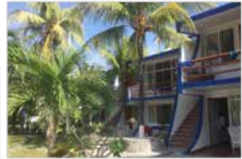
Edificio del bungalows. Fuente: D. G. Adame, D. Leonardo y B. Rivera.
