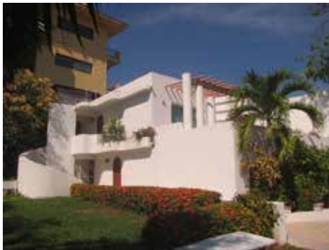
Figura 5.55 Techos planos en bungalós Adelamar . Fuente: Archivo personal.
