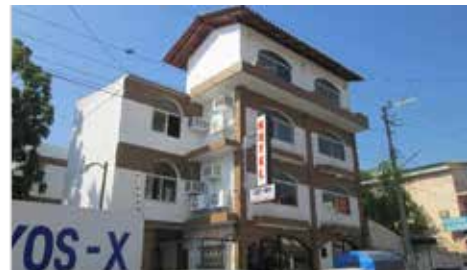
Figura 5.62 Uso de techos plano e inclinado en hotel Gaby Inn . Fuente: D. G. Adame, D. Leonardo y B. Rivera.
