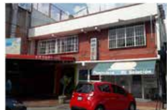
Fachada principal del hotel. Fuente: A. Ortega y U. Rosas.
