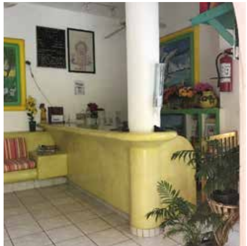
Figura 6.90. Extinguidor situado en la recepción del hotel Rossey . Fuente: Natalia Ocampo.
