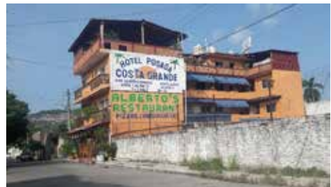
Figura 5.63 Uso de techos plano e inclinado en Posada Costa Grande . Fuente: B. Bárcenas y D. Díaz.
