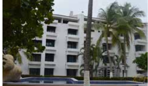
Figura 5.98 Hotel Ixtapa Palace con la implementación de vanos rectos en puertas y ventanas. Fuente: M. Ángel Quirino.
