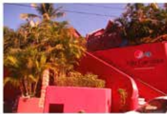
Acceso principal. Fuente: Archivo personal.
