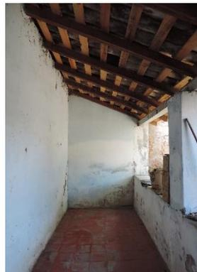
Detalles del interior, piso de loseta de barro con pintura en color rojo, tablerado en la cubierta y puerta interior, Visita realizada en el 2017.
