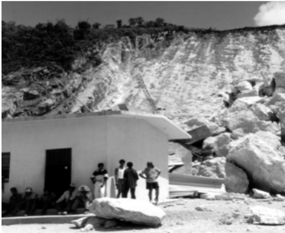
Imagen 7. Caído de las capas superficiales, inclinadas en el mismo sentido de la ladera natural del cerro el Tortuguero, en el Municipio de Macuspana, Tabasco
