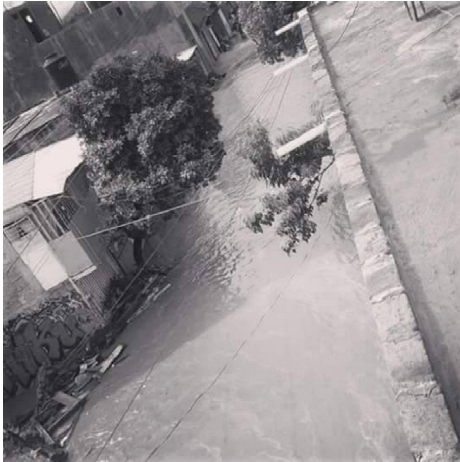
Imagen 30. Calle Tixtla durante las lluvias de “Ingrid” y “Manuel”, el agua del río Huacapa corre por la vialidad
