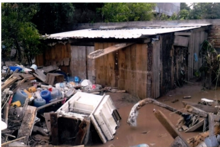
Imagen 35. Vivienda mixta, donde la cocina de madera fue afectada por la inundación y tuvo que ser derribada
