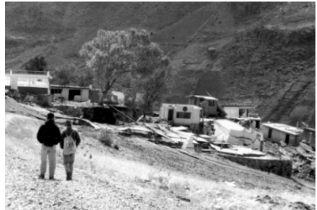
Imagen 9. Destrucción parcial del poblado debido al deslizamiento
