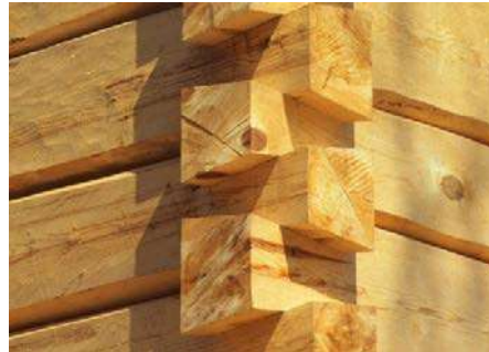
Fig. 2.4 Conexión machihembrada cola de pato.
