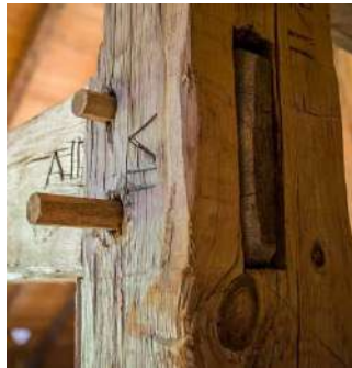
Fig. 2.3 Conexión machihembrada caja y espiga.
