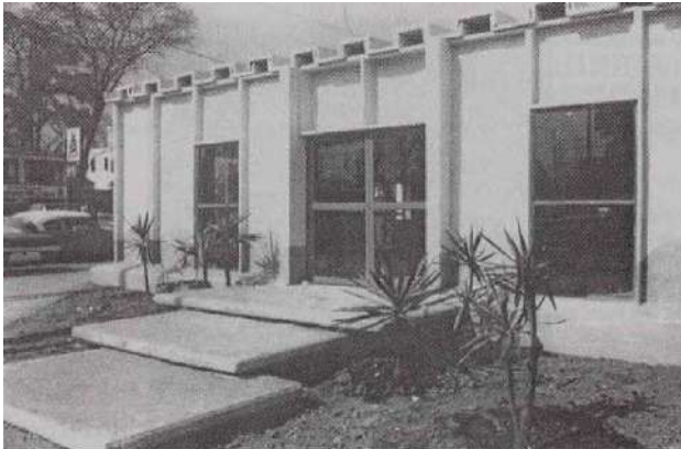
Fig. 1.8 Vivienda construida en México con paneles de ferrocemento (Naaman, 2000).
