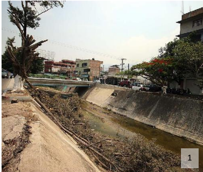
Imagen 1, 2 y 3. Tala de árboles ubicados en el Rio Huacapa, sin justificación sustentada.
