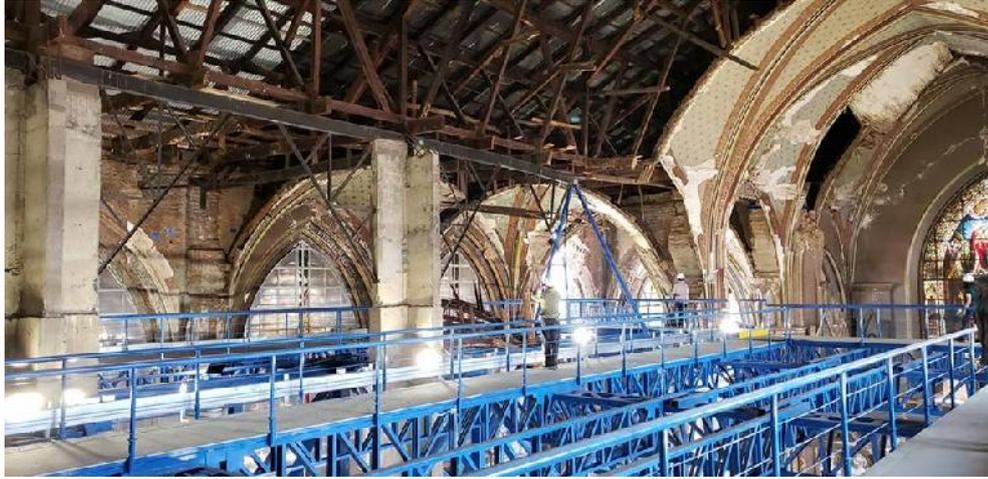
**Imagen IV.18. Plataformas de estructura de estabilización de la Basílica del Salvador, interior.**
