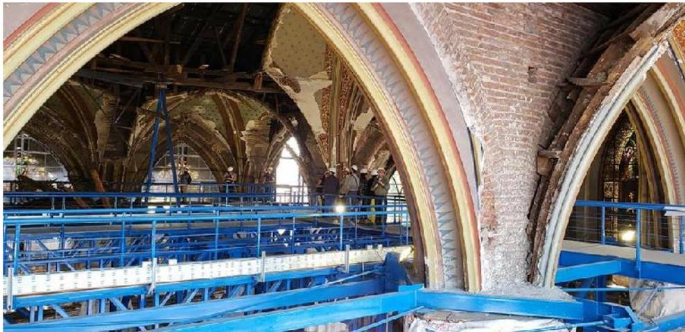
**Imagen IV.19. Plataformas de estructura de estabilización de la Basílica del Salvador, interior.**
