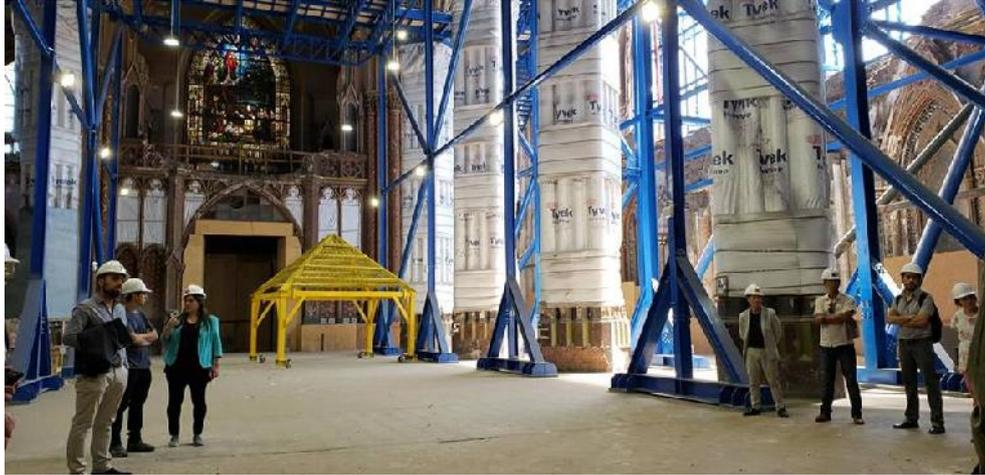
**Imagen IV.15. Estructura de estabilización de la Basílica del Salvador, interior.**
