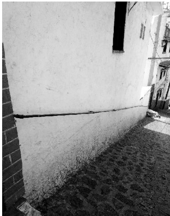
Fotografía 19: Foto de detalle de improvisación de un barandal en cale la Guadalupe.
